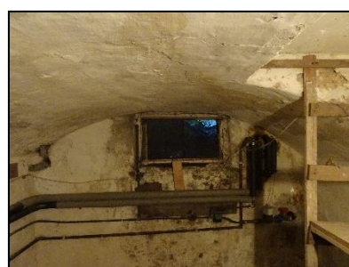
Figuur 19. De kelder van Dorpsstraat 38 is te bereiken via een opening in het raam.
