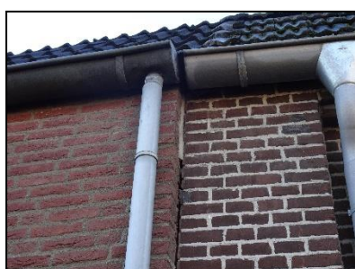
Figuur 17. Een dilatatievoeg in de muur van de woningen.
