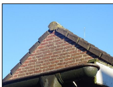
Figuur 18. Overhangende dakpannen bij een van de woningen.
