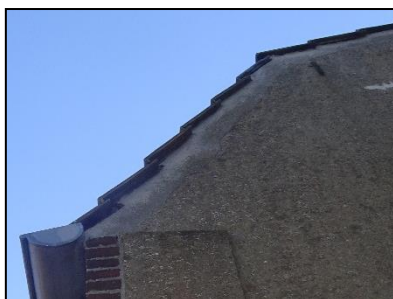
Figuur 12. Overhangende dakpannen bij een van de woningen.
