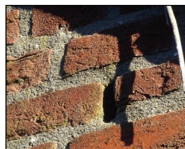
Figuur 22. Een stootvoeg in de muur van de garagebox.
