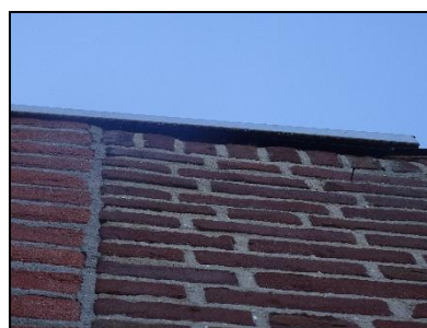
Figuur 16. Opening langs de dakrand van het partycentrum.
