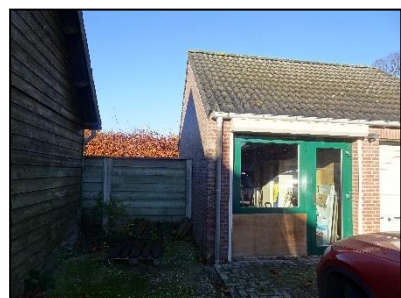
Figuur 8. Garageboxen, kijkrichting west.
