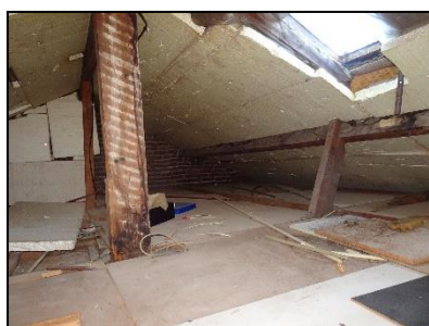
Figuur 20. De zolder met dakbeschot van Dorpsstraat 38.
