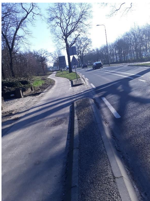
foto 3: Reparatievak ter hoogte van huisnr. 35
