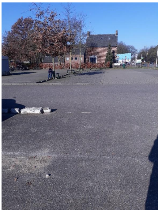
foto 1: parkeerterrein. Asfalt en klinkergedeelte
