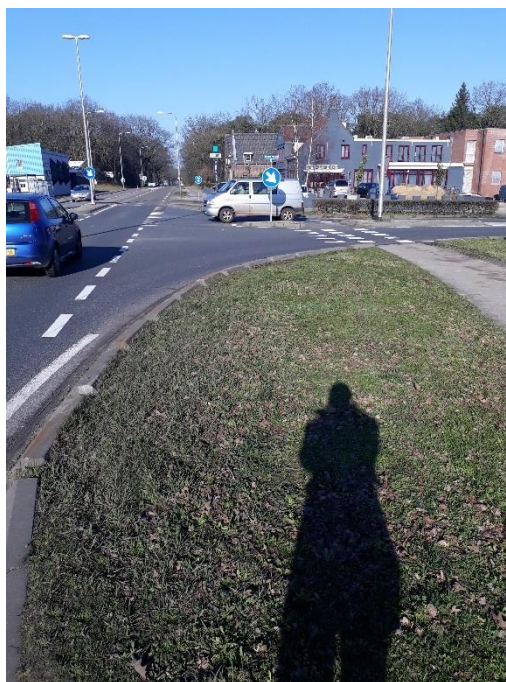
foto 2: aansluiting N271 met Wezerweg gezien vanaf zuidzijde
