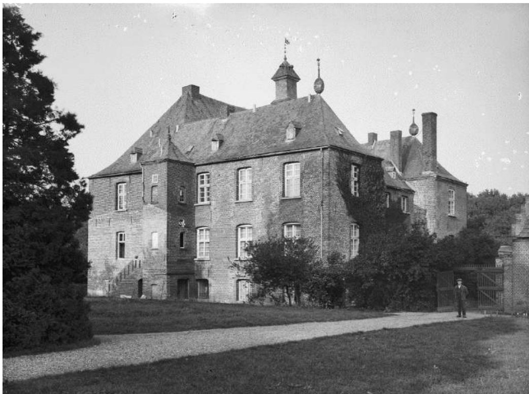
Ongedateerde foto van het kasteel na de afbraak van de neo-romaanse kapel. Op de westgevel zijn de bouwsporen van de aanbouw tussen torentje en kapel nog zichtbaar. Links van het torentje de door de paters jezuiten gebouwde buitentrapp die naar de tuin voerde. Uiterst rechts de heestergroep op de padsplitsing. Foto coll. Ton Wijers.
