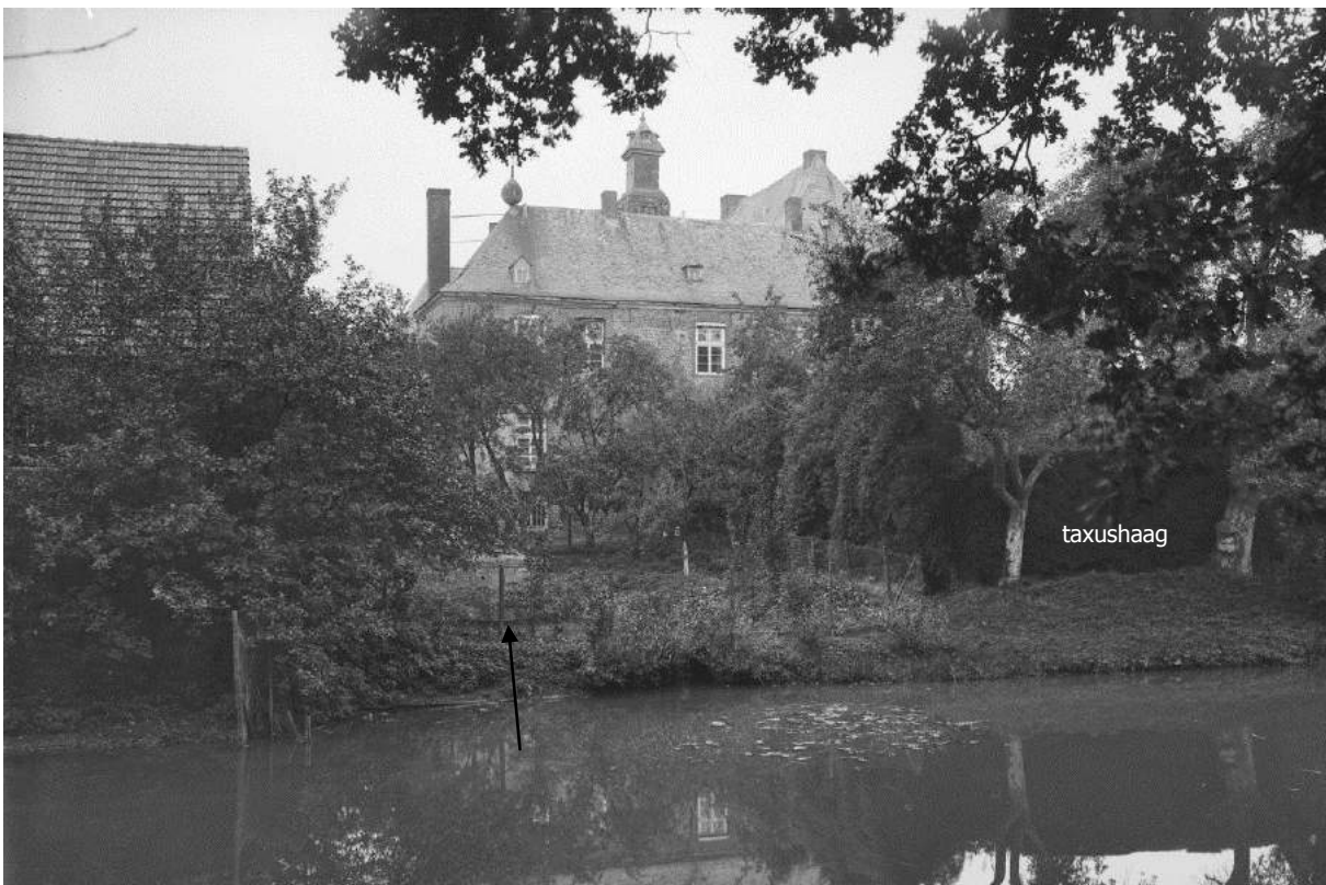
De vijver op de plek van de vroegere verbindingsgracht tussen huisgracht en buitengracht, eerste kwart 20e eeuw. Langs de buitengracht is de vijver afgedamd van de buitengracht en hier alleen middels een duiker mee verbonden. De vijver is omgeven door een rasterwerk met daarachter de taxushaag. In de vijver is een decoratief eendenhok (zie pijl) zichtbaar. Foto coll. Ton Wijers.
