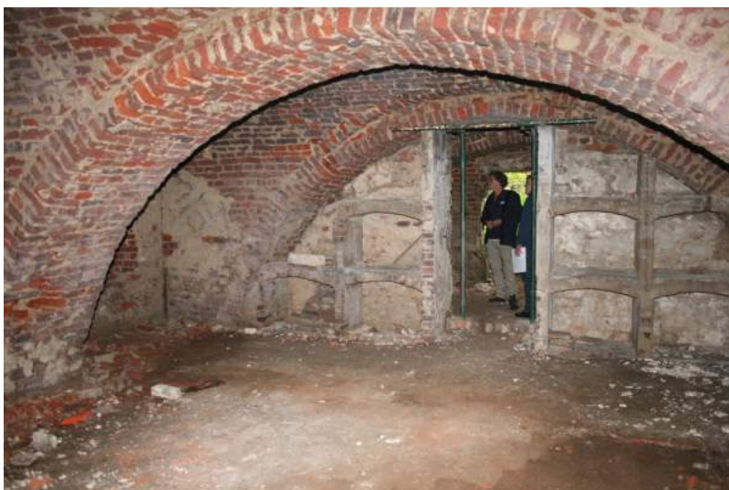
De kelder onder de Ridderzaal met vakken voor wijopslag(foto sept 2013).
