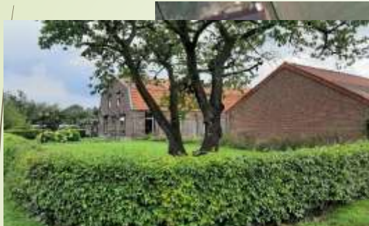
Woonhuis en schuur aan straatzijde
