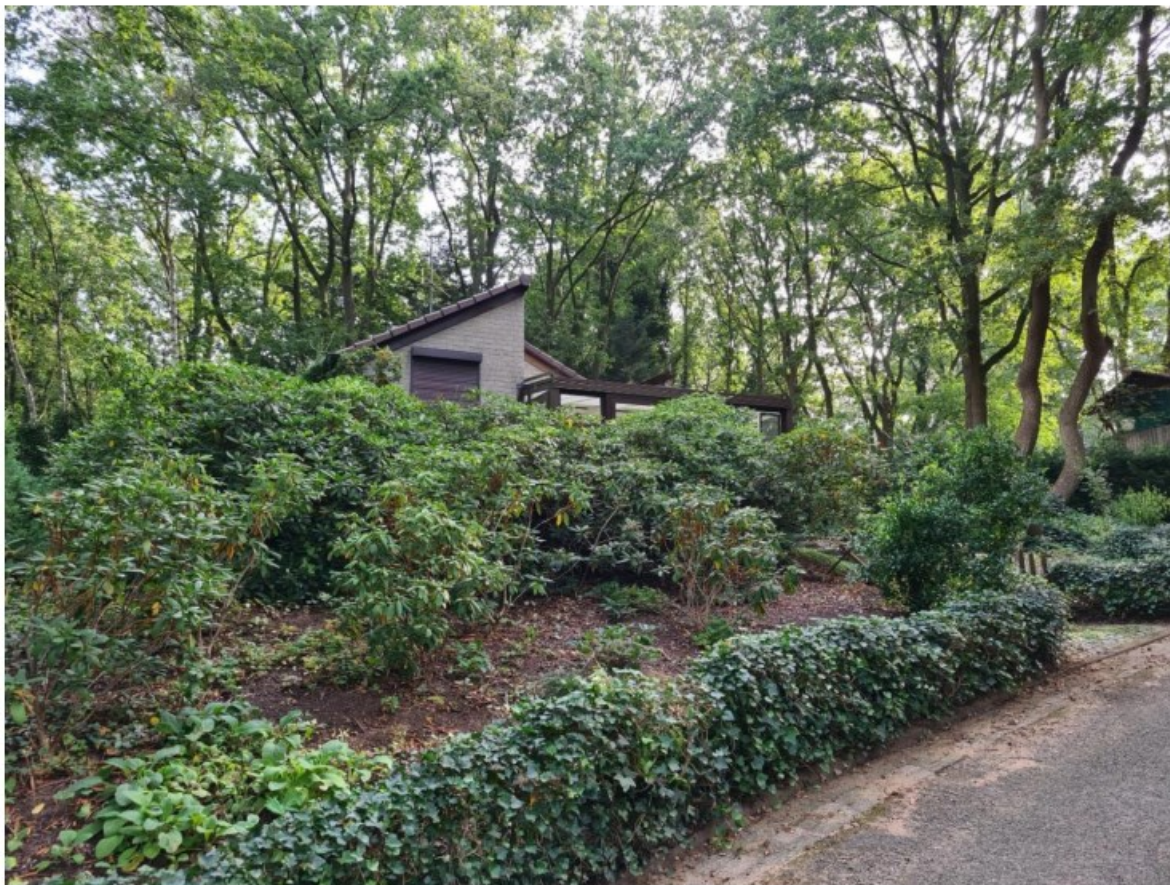
Nummer 34, het toevoegen van een serre aan de kopse kant van de oorspronkelijke bouwmassa, zichtbaar vanaf de ontsluitingsweg, doet afbreuk aan de hoofdvorm en de oriëntatie van de bebouwing (foto: Dorp, Stad en Land, 2021)
