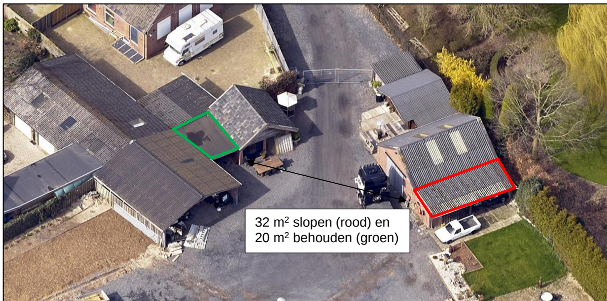
Afbeelding 4. Sloop overkapping achterzijde bijgebouw 1 in ruil voor legalisatie overkapping tussen gebouwen 3 en 4
