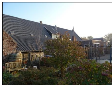
Figuur 4. Achterzijde bebouwing.
