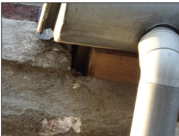
Figuur 13. Ruimte onder dakgoot hoofdgebouw is toegankelijk voor vleermuizen.
