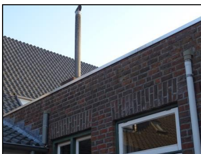
Figuur 6. Daklijst langs dakrand bebouwing.
