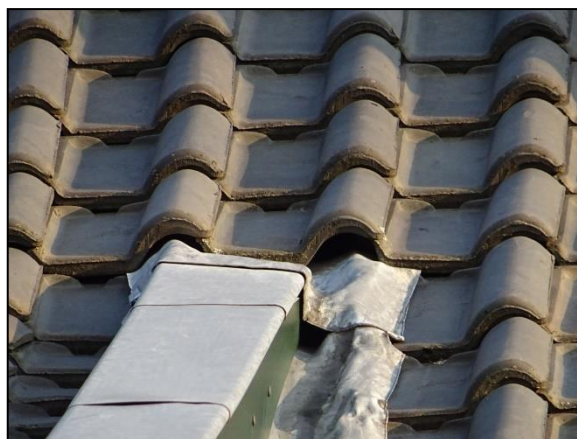
Figuur 9. Ruimte onder dakpannen.
