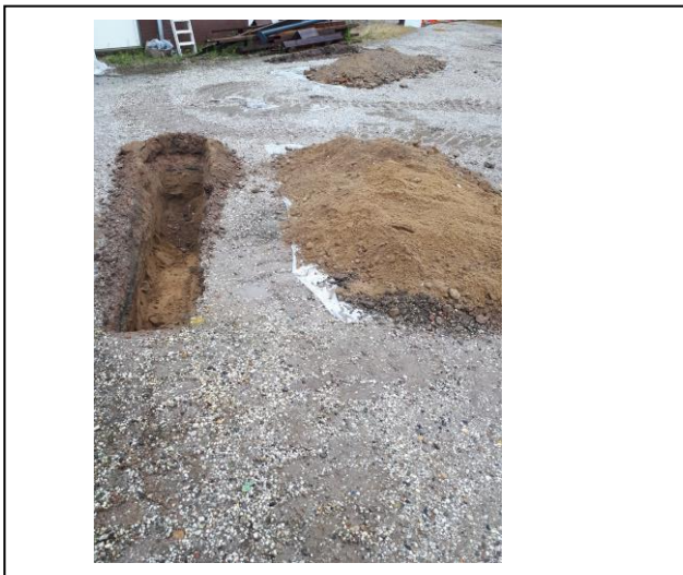
Foto 1. Asbestinspectiesleuf 1
