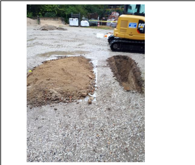
Foto 5. Asbestinspectiesleuf 4
