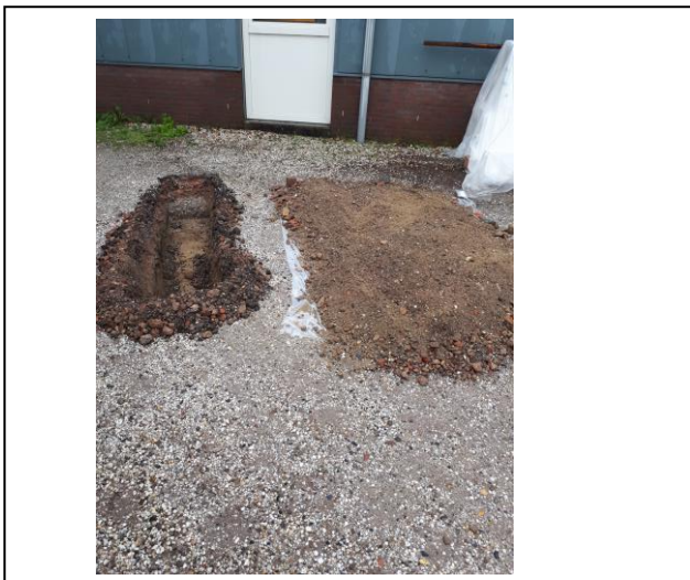
Foto 2. Asbestinspectiesleuf 2
