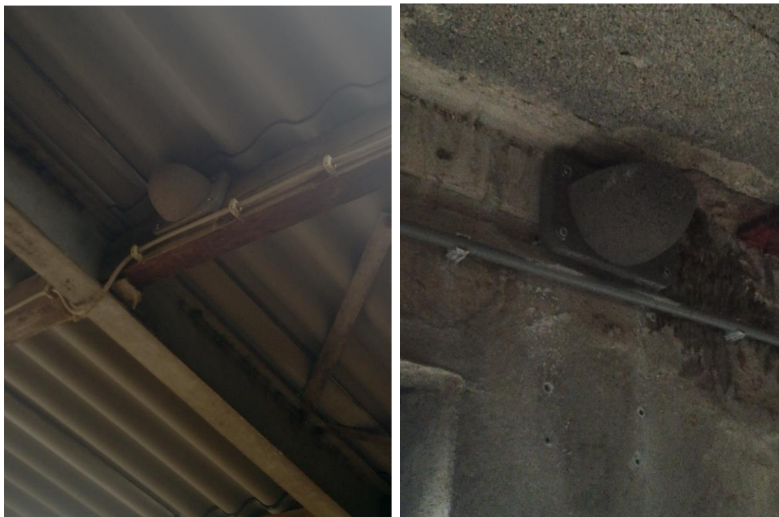
Figuur 3. Twee van de 10 geplaatste nestkommen.
