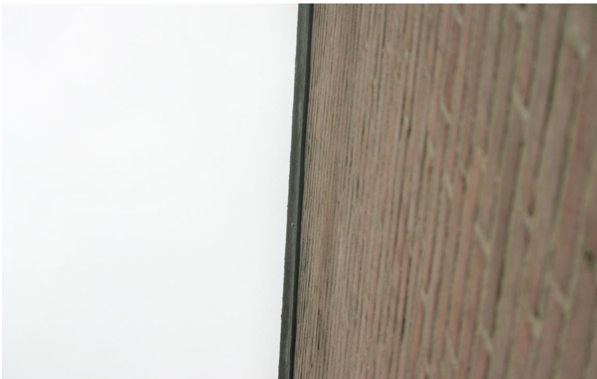
Figuur 4.2.2. Het golfplaten dak sluit overal nauw aan op de kopse gevels. Vleermuizen kunnen hier niet onder kruipen, om de achterliggende spouw te bereiken.
