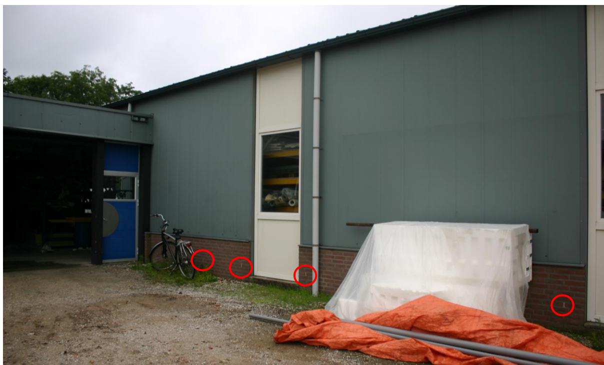
Figuur 4.2.1. In loods 1 zijn geen openingen aanwezig anders dan de open stootvoegen op kniehoogte (te laag voor vleermuizen). Deze zijn afgedicht met roostertjes, waardoor ook kleine, grondgebonden zoogdieren niet de spouw in kunnen.
