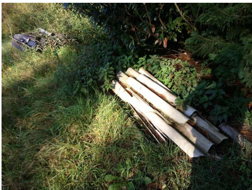
Foto, asbestverdacht plaatmateriaal
