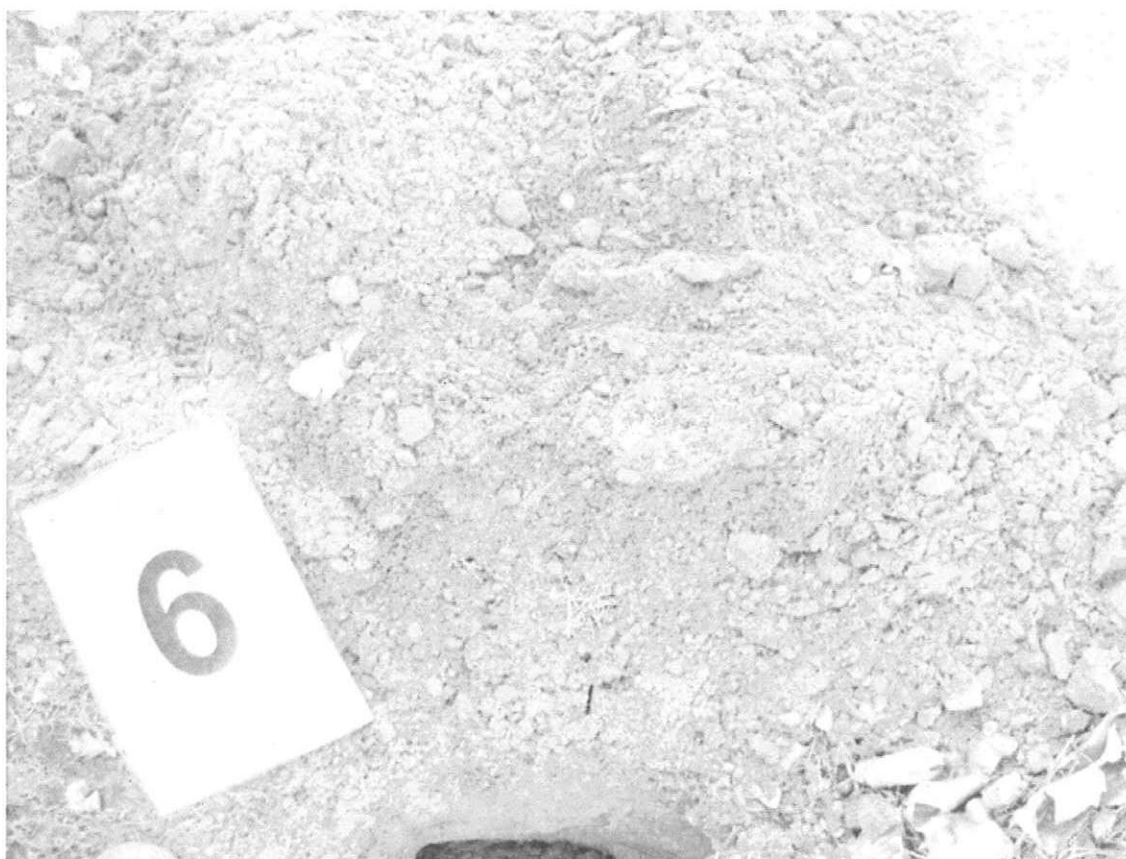
foto 8: uitkomend materiaal inspectiegat 6
