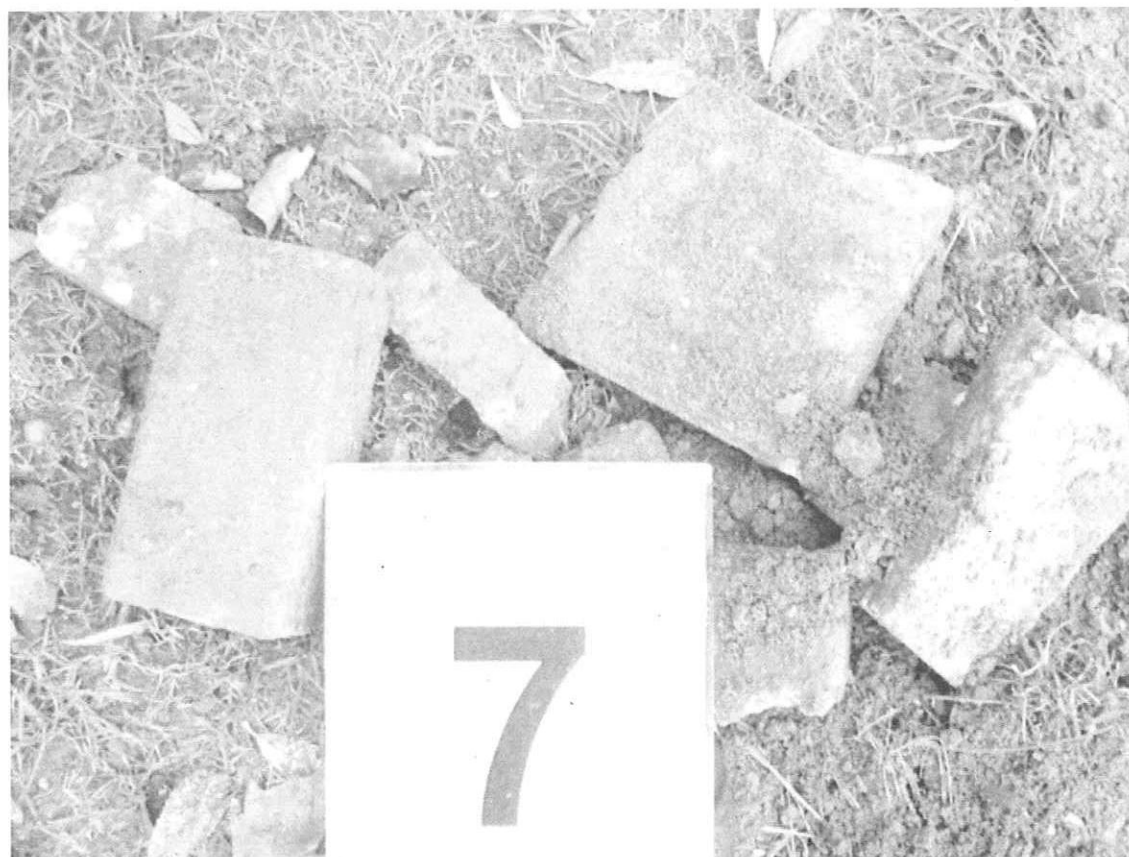
foto 10: uitkomend materiaal inspectiegat 7
