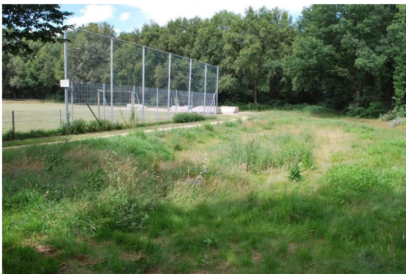
Foto 10: regenwaterbuffer (laagte) noordoostelijk van sportveld
