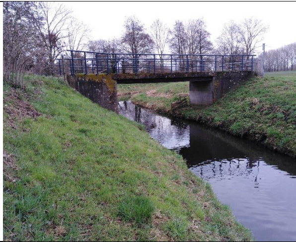
Brug over sleybeek (west)
