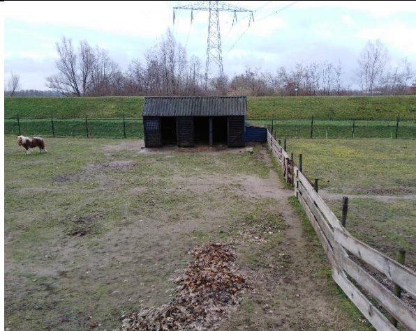
Ongefundeerd gebouw (oost)
