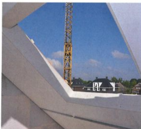
Fabrieksmatig aangebracht dakvenster met aftimmering
