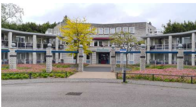
Figuur 22: Bestaande appartementen aan Rustoord
