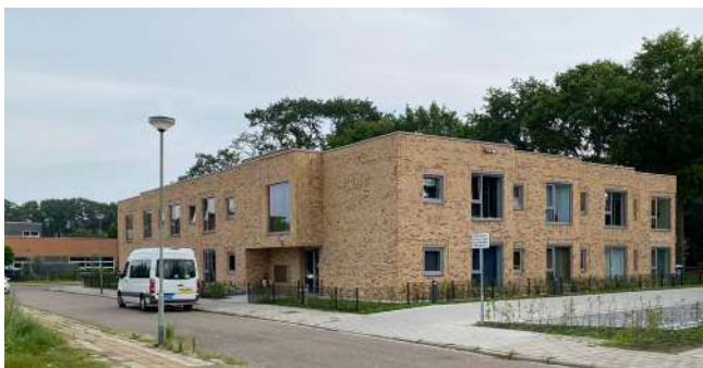
Figuur 21: Bestaande appartementen aan Rustoord
