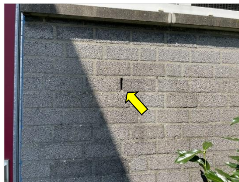
Figuur 4.4 Stootvoeg in bebouwing grenzend aan onderzoekslocatie.
