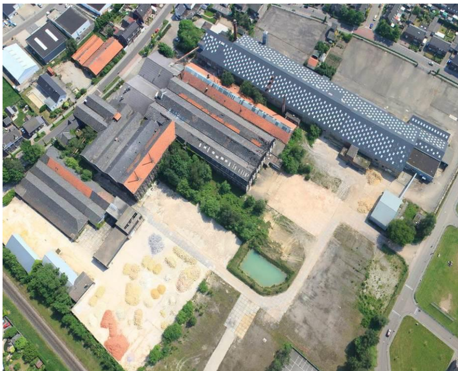
Afbeelding 2.2.: een blik op het fabrieksterrein van mei 2013. Inmiddels is een groot deel van de bedrijfsbebouwing gesloopt.
