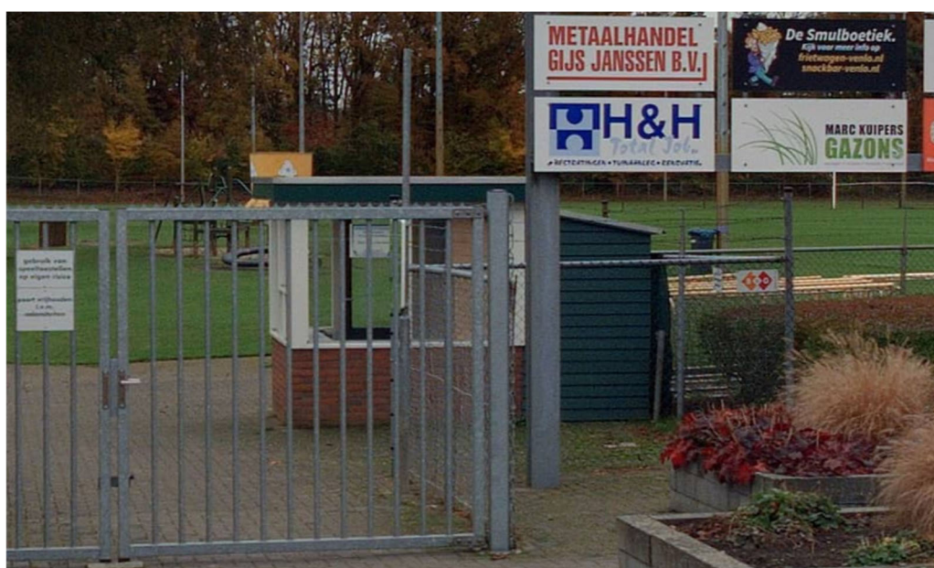
• Afbeelding 22: te slopen entreegebouwtje (bron: cyclomedia)
