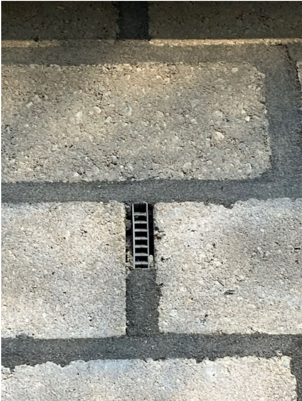
• Afbeelding 10: bijenbekjes in de gevel van het kleedlokaal
