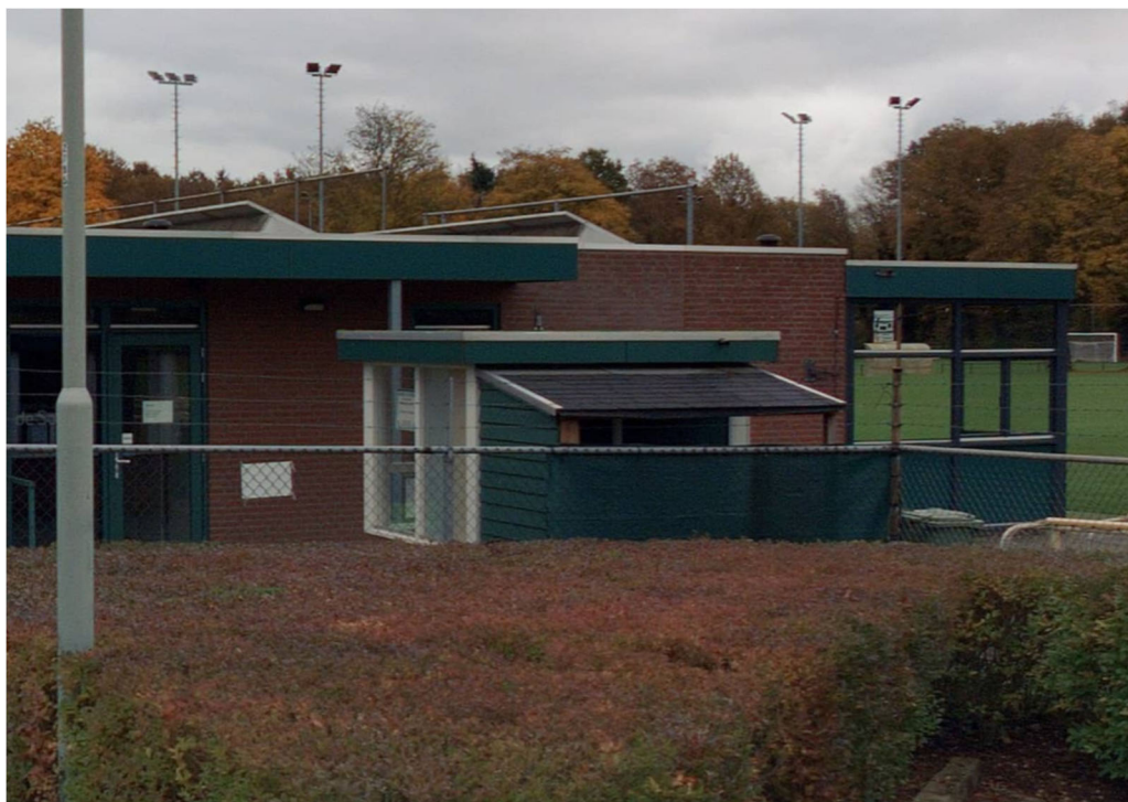
• Afbeelding 23: te slopen entreegebouwtje (bron: cyclomedia)
