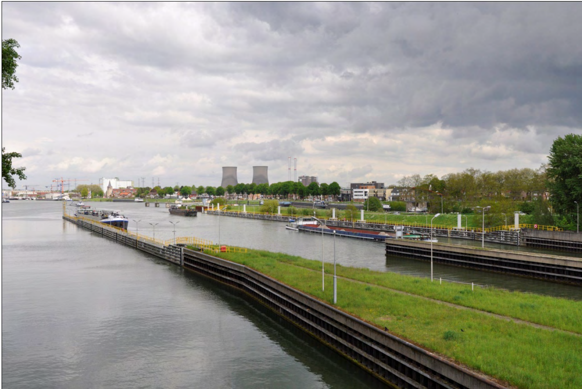
Afbeelding 8 Sluis bij Maasbracht (foto: ARCADIS)
