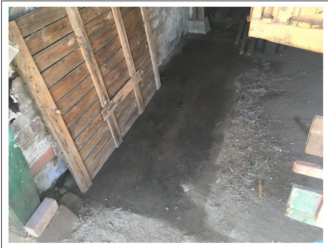
Foto 7. Situering vml. dieseltank (deellocatie B)
