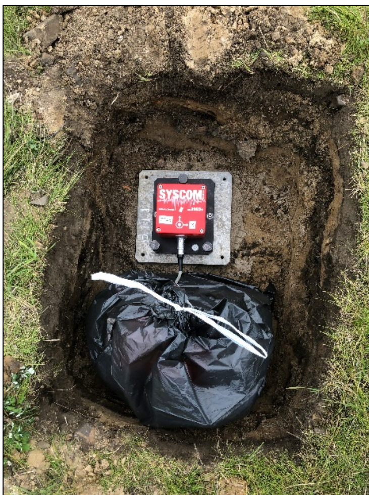
Figuur 3.2: De trillingssensor ingegraven bij meetpunt 2
