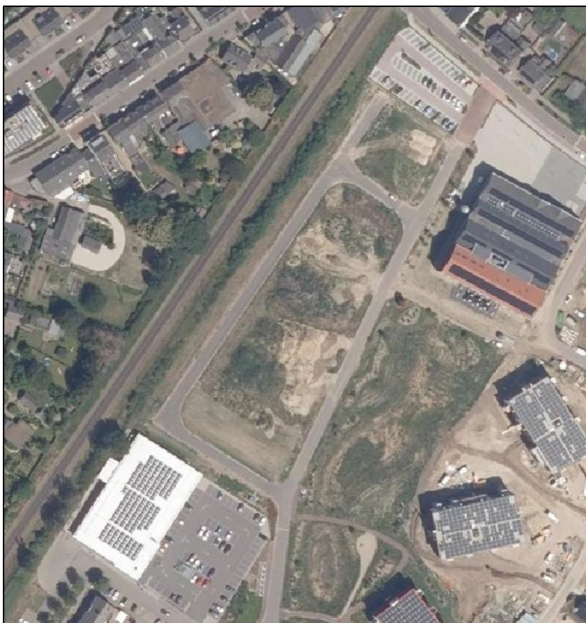
Figuur 2.2: Luchtfoto van de bouwplanlocatie (bron ruimtelijkeplannen.nl)
