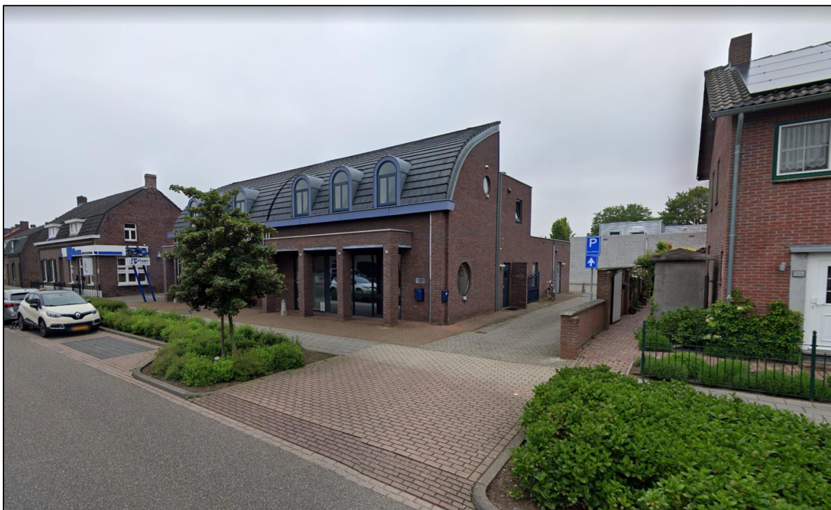
Foto bestaande bebouwing, gezien vanuit het zuiden. (Bron: Google Streetview, mei 2019)
