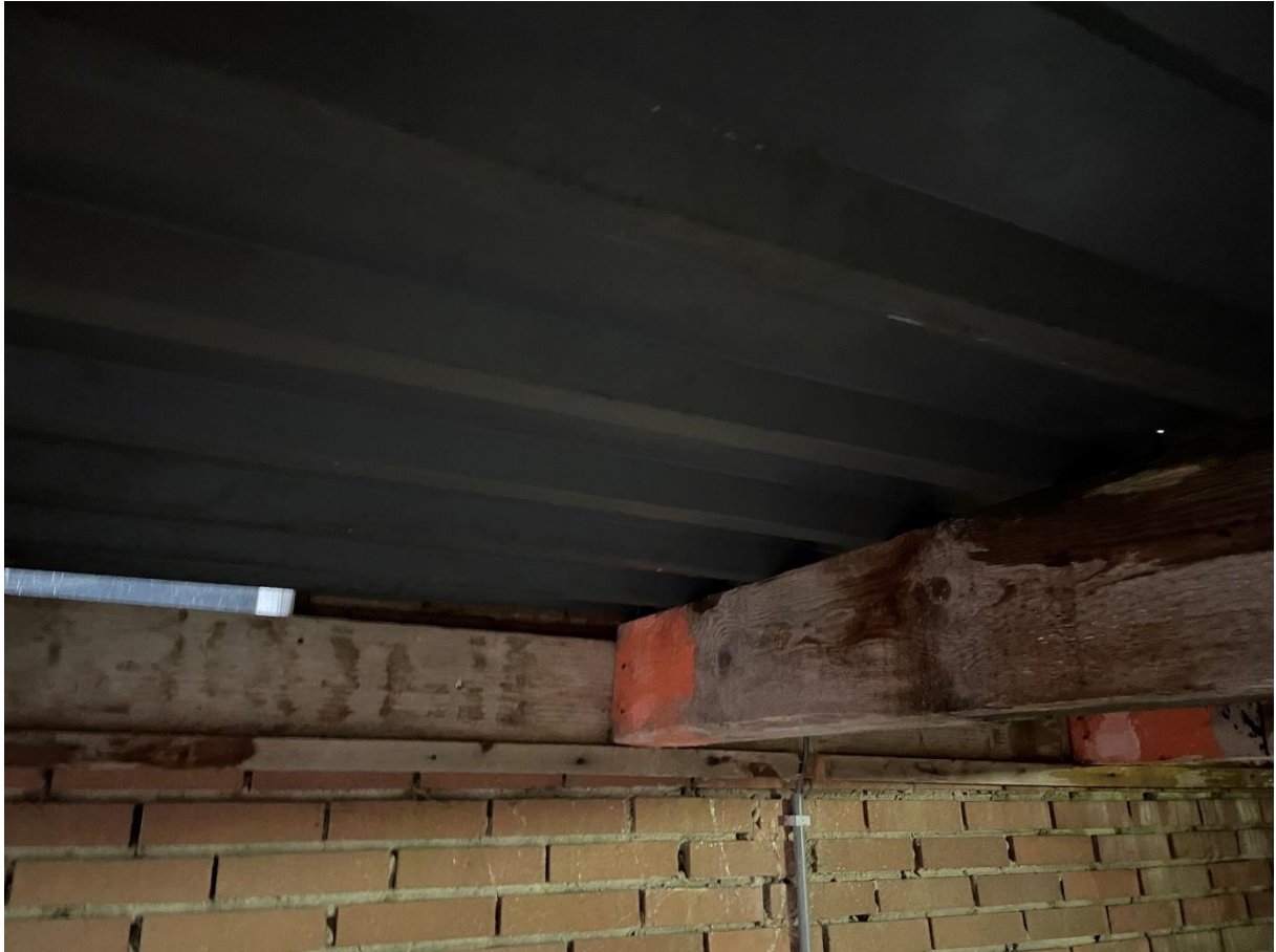
Foto 19: de bouw van de overkapping bestaat uit houten balken met erop een metalen profielplaat.
