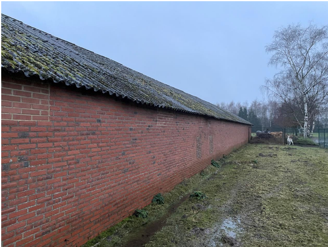
Foto 4: in de steens muren zitten geen scheuren of openingen naar binnen toe. Ten noorden is een klein veldje voor het houden van herten.
