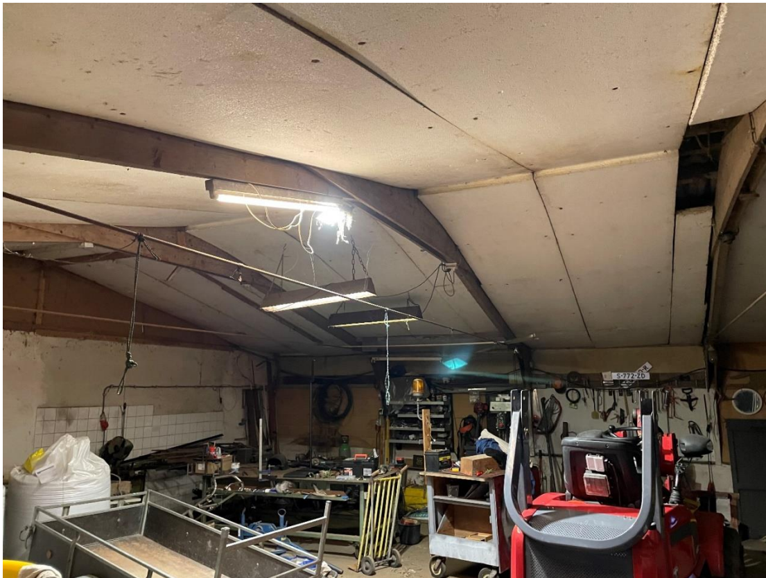
Foto 8: werktuigenstalling in de zuidelijke schuur.
