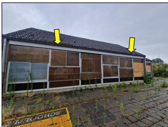
Figuur 5-1. Ruimte tussen de dakgoot en de dakpannen geschikt voor huismus.
