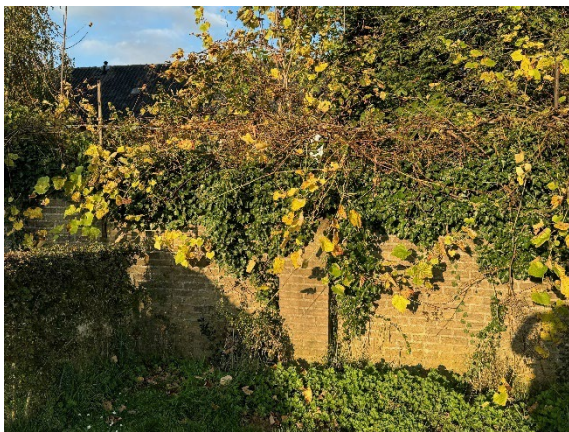
Figuur 17 Kloostermuur op de perceelsgrens, hoog 1,80 m, ter hoogte van kavel 1, ter plaatse opgemeten op 31 oktober 2024
