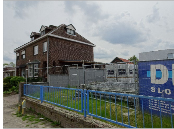
Figuur 10 Zijgevel Stationstraat 112
