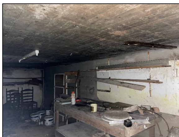
Foto 14. Ruimte onder gebouw
