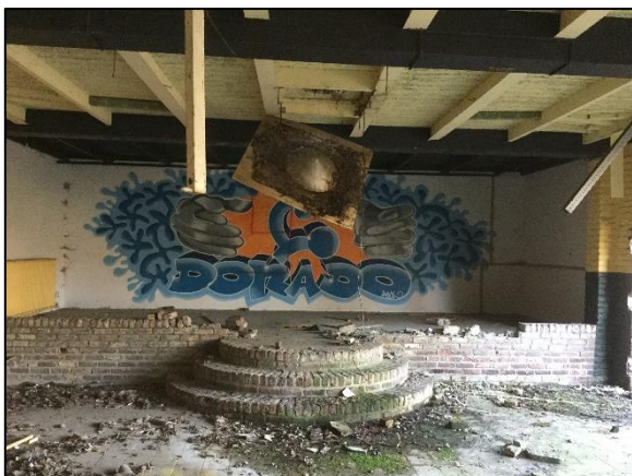
Foto 11. Het zuiden van het gebouw, meer intact
