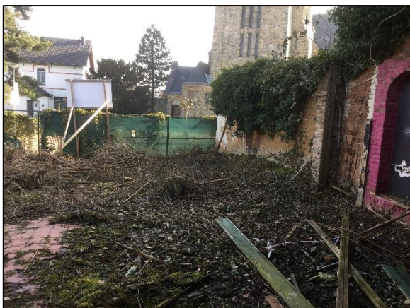
Foto 5. Muur en hekwerk in het oosten van het plangebied
