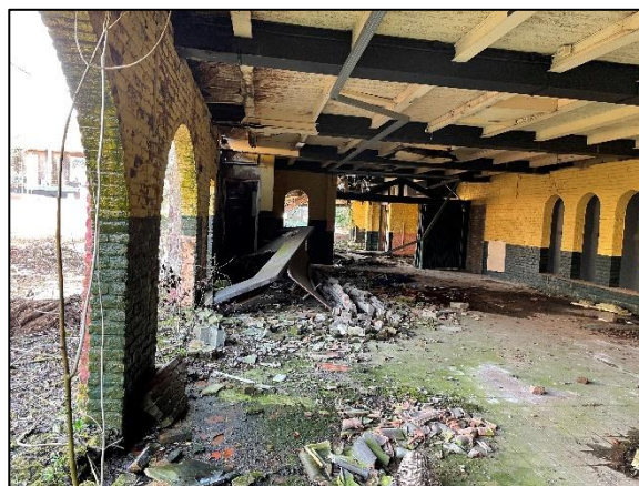
Foto 10. Het zuiden van het gebouw, meer intact
