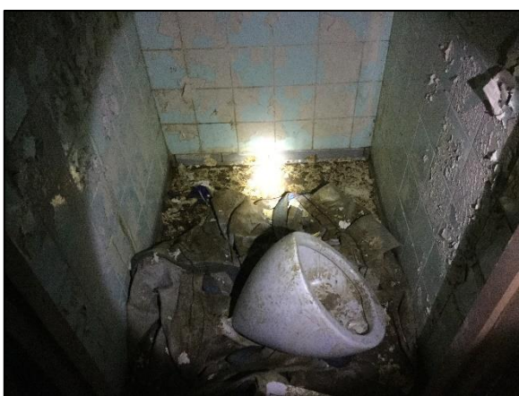
Foto 13. Ruimte onder gebouw
