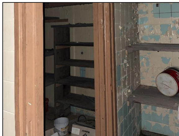
Foto 12. Ruimte onder gebouw
