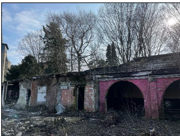
Foto 9. Het zuiden van het gebouw, meer intact
