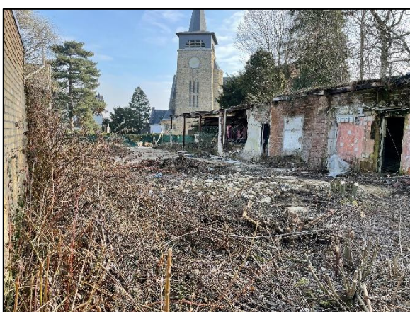
Foto 3. De afgezette vegetatie, braam en klimop (foto vanuit het zuidwesten richting het noordoosten)
