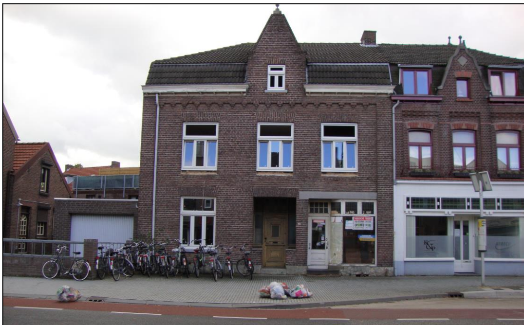
De voorgevel van het pand aan de Prins Mauritslaan 9
