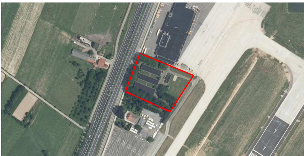
Luchtfoto plangebied (voor de sloop van de bebouwing) (bron: Microsoft Virtual Earth)
