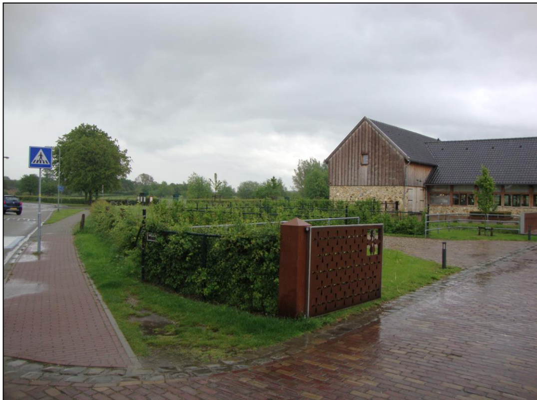
Entree Oude Pastorie: de aansluitend hieraan gelegen waterbuffers vormen het 'eindstation' van fase 1b.
