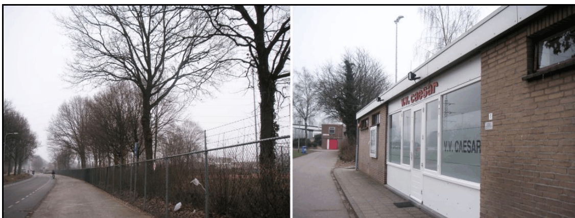
Afbeelding 3: Links de houtkant aan de rand van het sportpark, langs de Carmelstraat. Rechts één van de gebouwen binnen het plangebied. Het gebouw heeft open stootvoegen, maar is tevens aan alle zijden verlicht.
