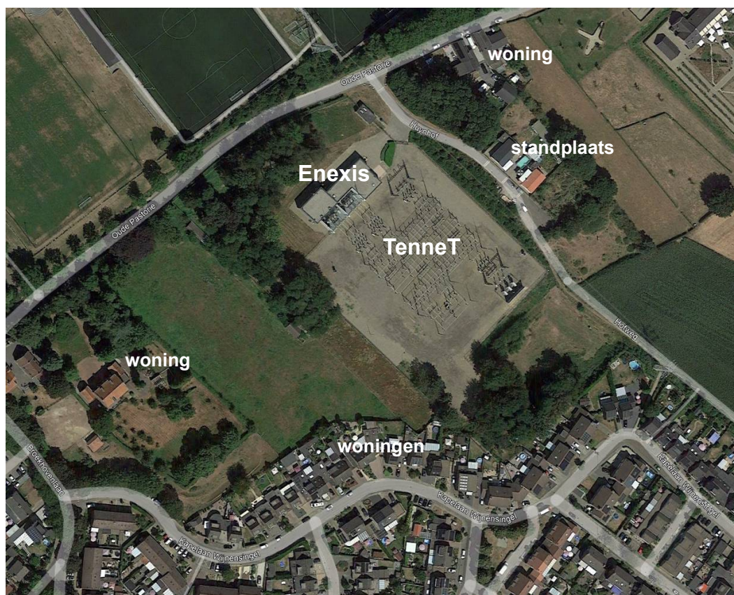
f2.1 Situering 150/10 kV station Beek en woonomgeving
