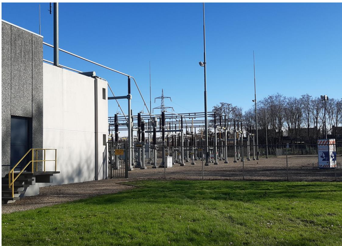
Figuur 3. Bestaande bebouwing en de schakeltuin. Op de achtergrond zijn de bomen te zien die zich in het zuidoostelijke gedeelte van het gebied bevinden.
