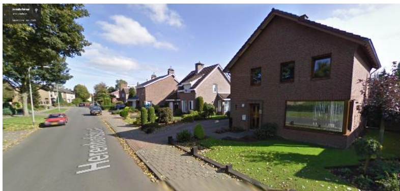
Woningen aan de Herenhofstraat (tegenover het plangebied) (Bron: google streetview)
