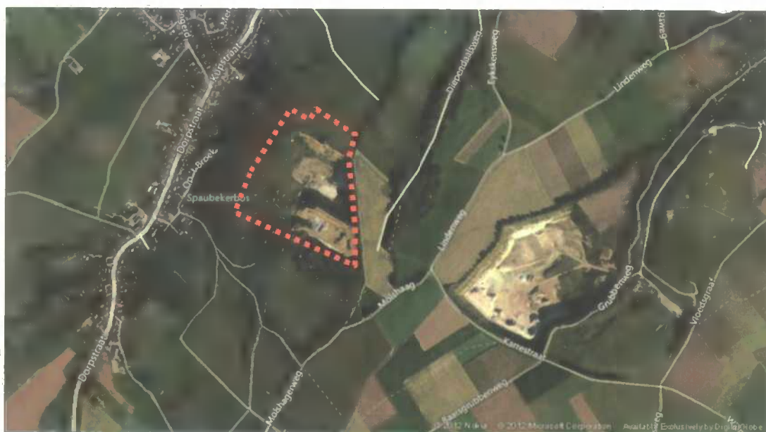
Figuur 1.1 Locatie van de groeve Spaubeek waar voor het gedeelte binnen de rode lijn ontgrondvergunning wordt aangevraagd.
