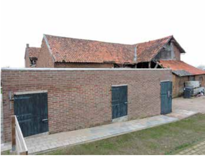
13. Tegen de stalvleugel is deze moderne stalvleugel gebouwd. De massa springt sterk uit t.o.v. het oorspronkelijke carré-vormige gebouw
