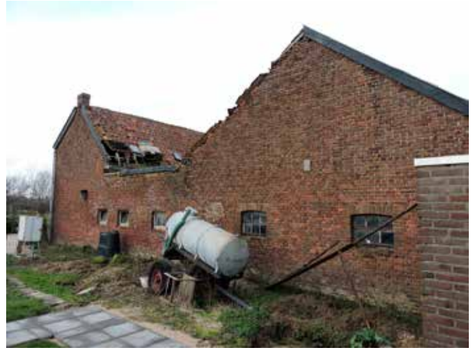
14. De zijgevel van woonhuis en schuur en de verbindende muur daar tussen, later uitgebouwd tot stal
