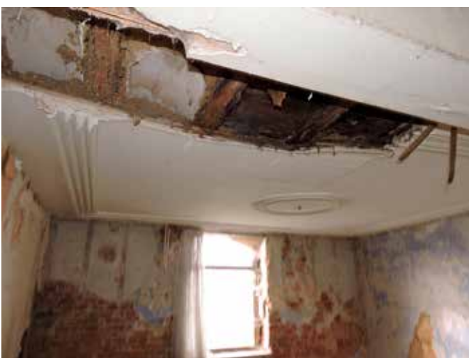
38. De kamer aan de straat laat een zwaar beschadigd plafond zien met sierlijsten en een rond rozet, met daaronder een ouder gespelderd plafond, uitgevoerd in leem
