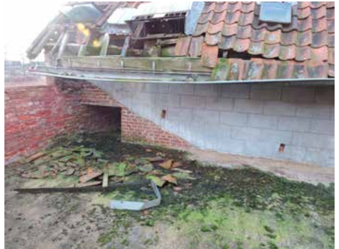
20. Tegen de achtergevel van de schuur aan de straat tekent zich het oorspronkelijke lessenaardak af van de stal
