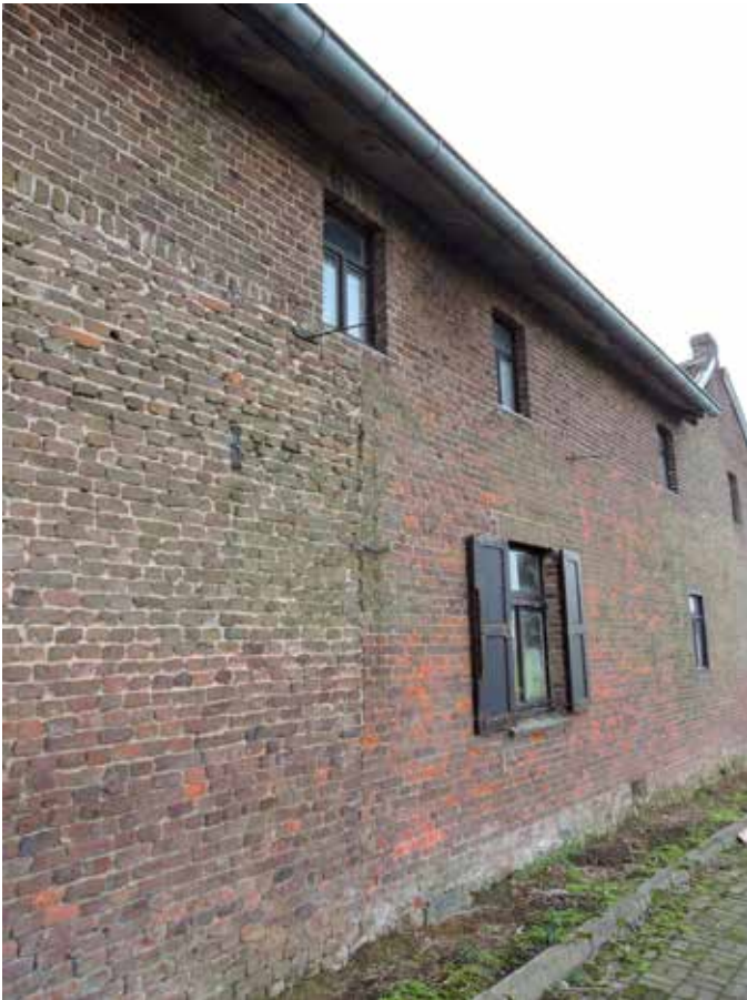
9. Die oude hoogte is ook waarneembaar bij de gevel van de schuur achter het woonhuis door de laag strekken. Bovendien blijkt dat die ouder is dan de versterking van het huis
