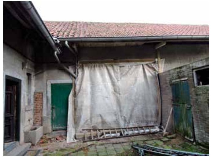
18. De geblindeerde poort van de schuur en rechts de moderne stal tegen de zijmuur
