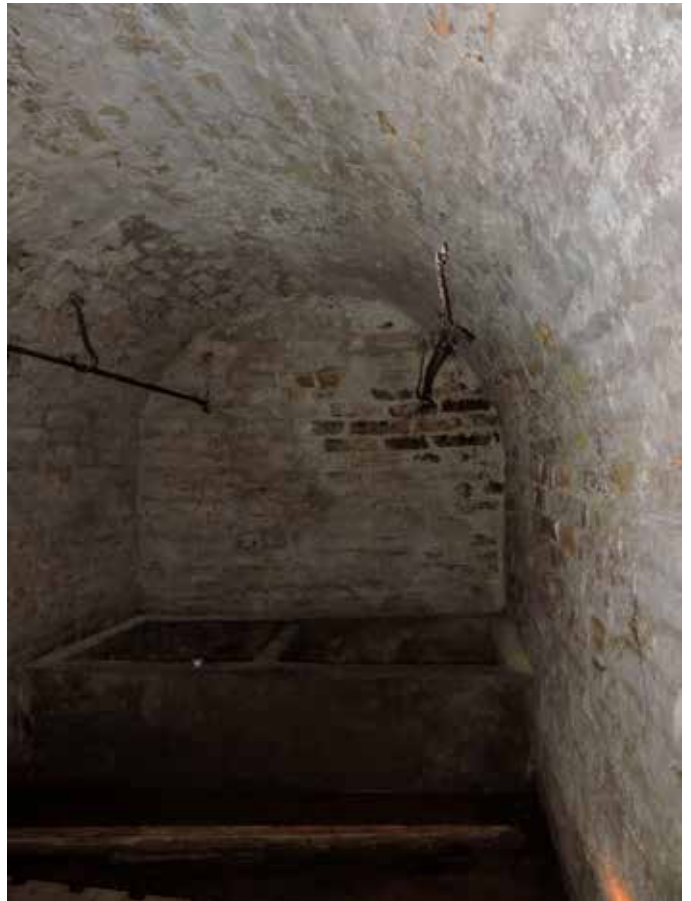
33. Dit later ingebrachte keldertje is 19de eeuws, en helemaal uitgevoerd in baksteen. Tegen de kopse wand staat een pekelbak
