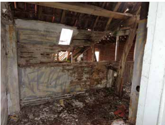
48. De ruimte boven de kamer meteen links naast het halletje met rechts het schoorsteenkanaal van de dubbele haard in de voorkamers
