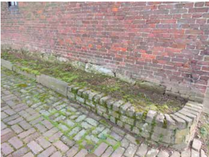
7. De plint laat aan de linkerkant grote blokken mergel zien, die horen bij de fundering en sokkel van het versteende vakwerkhuis dat de kern vormt van het complex
