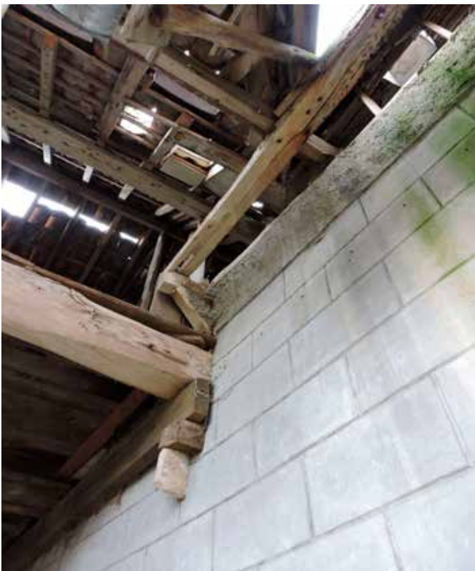
25. De aanhechting van de daken van scguur een woonhuis met een kilgoot, gevolg van de verstenen en het optrekken van een nieuwe voorgevel en gedeeltelijk nieuwe zijgevel
