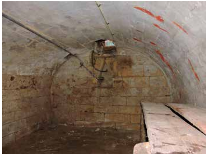
29. De in mergel uitgevoerde tonggewelfde kelder dateert uit de vroege 17 de eeuw. opmerkelijk zijn de aan beide zijden aanwezige lampnissen met een spitsboog
