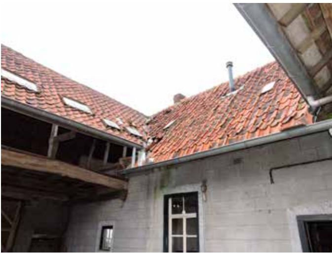
25. De aanhechting van de daken van scguur een woonhuis met een kilgoot, gevolg van de verstenen en het optrekken van een nieuwe voorgevel en gedeeltelijk nieuwe zijgevel
