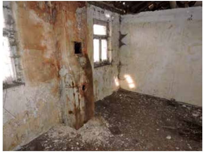
45. Schoorsteenkanaal boven de keuken
