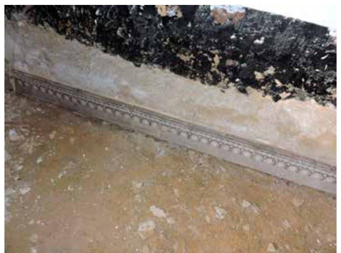
39. De plint bestaat uit hardgebakke gefigureerde tegeltjes
