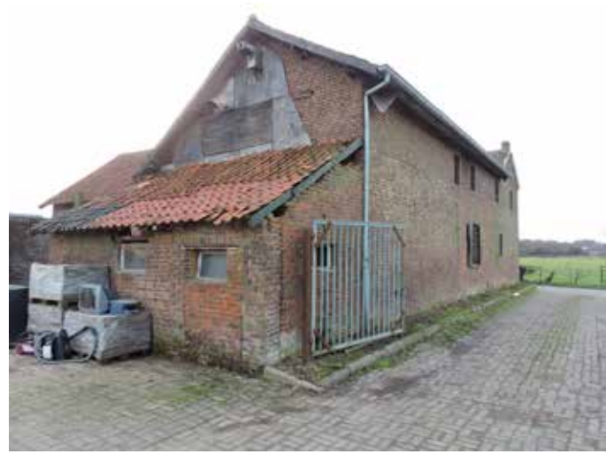
10. In de topgevel van de schuur is een restant zichtbaar van de oorspronkelijke jukdekbalk van het spant, en de latere ophoging van het dak, in combinatie met de zijmuur. De aanbouw met lessenaardak is nog weer jonger
