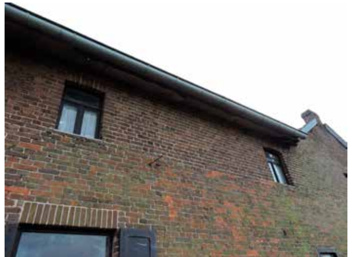
8. Op verdiepingshoogte is te zien dat de woonhuisvleugel in tweede instantie, na het verstenen van het vakwerk, nog een keer is opgehoogd
