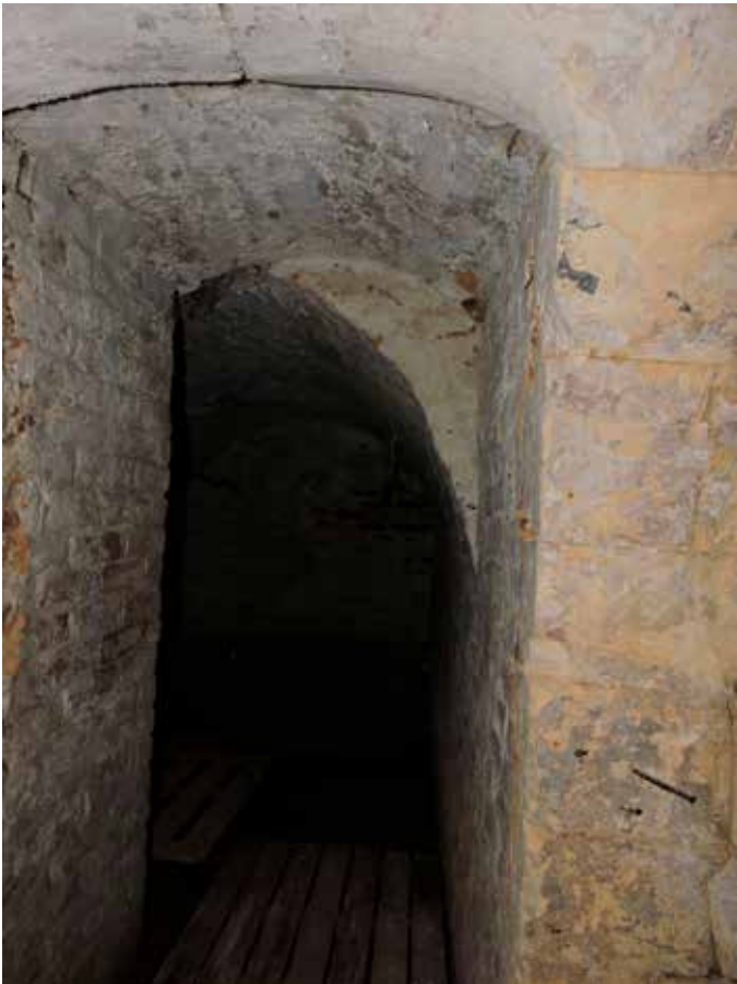
32. Aan de oostkant is een doorbraak gemaakt naar een tweede, latere kelder
