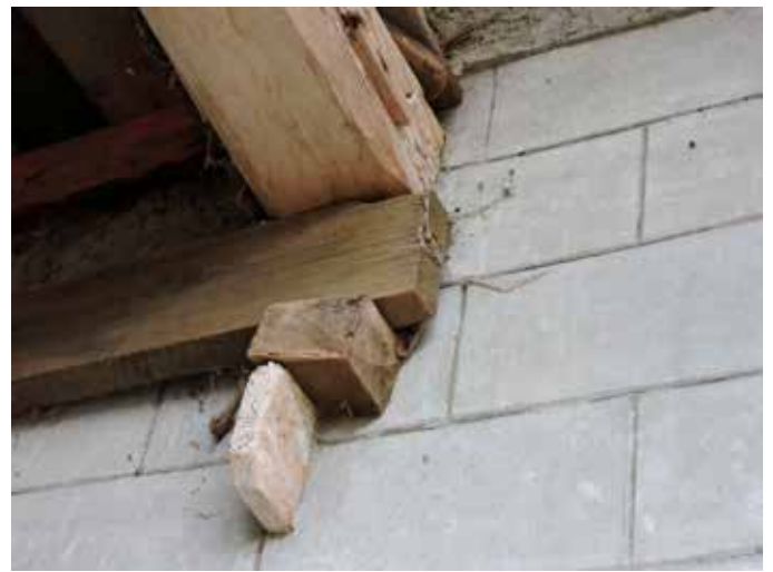
26. De oplegging van de balk boven de poort is uiterst inventief maar zeer instabiel
