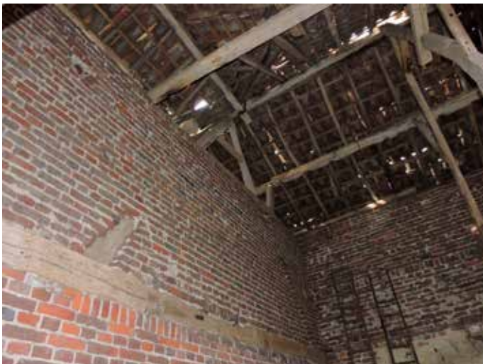
58. De achtergevel van het versteende woonhuis, met enkele restanten van het oorspronkelijke vakwerk
