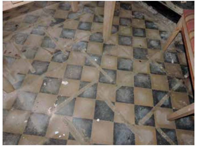
37. De vloer is belegd met in patroon verwerkte cementtegels van rond 1920
