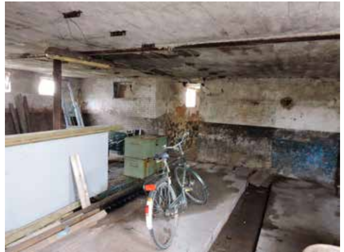
59. De aangebouwde moderne stalvleugel richting straat gezien
