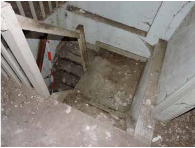
44. De trap gezien vanaf de verdiepingsvloer
