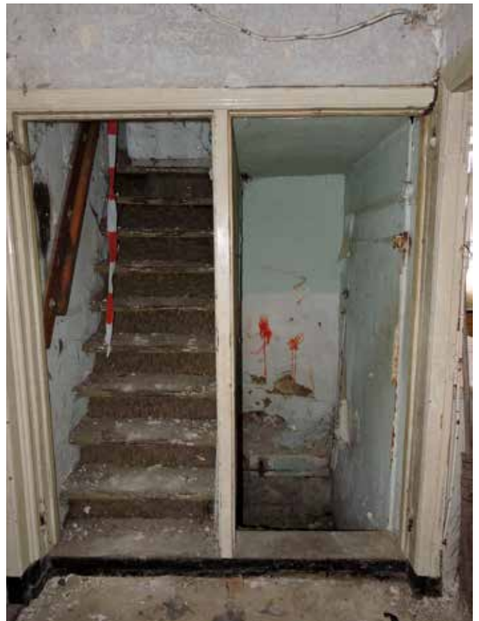
43. De trap naar de verdieping, met rechts de ingang naar de kelder
