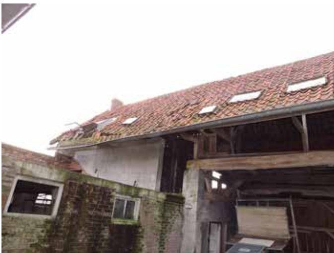
21. De achtergevel van de schuur aan de straat, met rechts de poort
