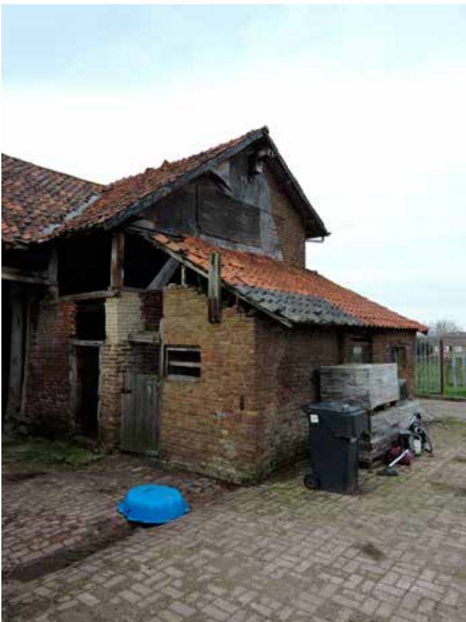
11. De massa van de andere kant gezien, met duidelijk de oorspronkelijke vakwerkstructuur
