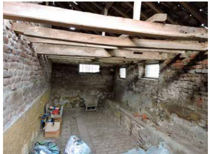
53. In de schuur, naast de poort aan de straat, is een oudere stal aanwezig
