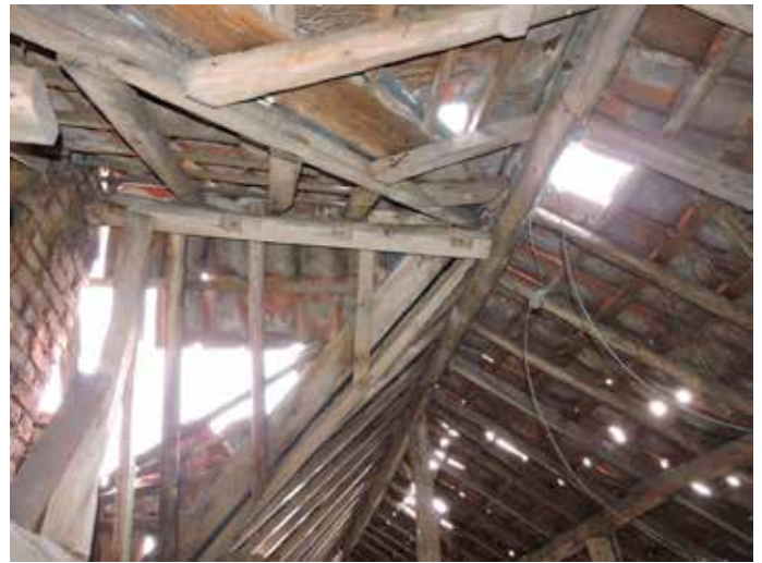
51. De aanhechting van woonhuisdak, links, op het dak van de schuur aan de straat
