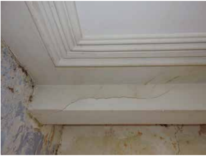
40. Detail van het stucplafond
