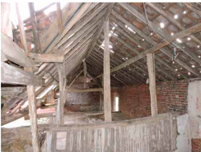
52. De kap van de schuur
