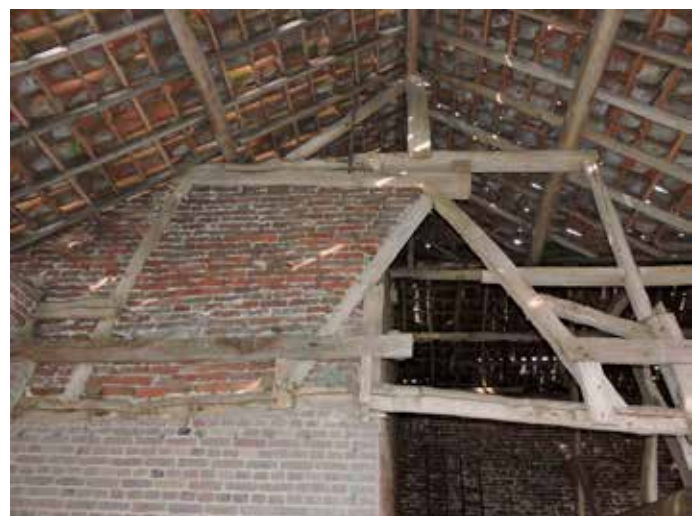
55. De constructie van wand en dak ontberen elke logica. Er is ook geen duidelijke fasering te ontdekken, wat het aannemelijk maakt dat er met bestaand materiaal een constructie is gemaakt die alleen functioneel moest zijn
