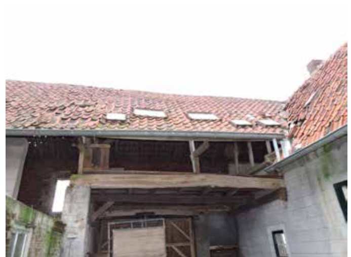
22. De overkapping van de poort
