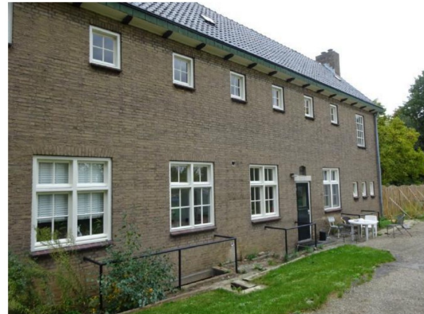
Figuur 4 - Zuidelijke gevel van de zuidelijke vleugel rondom de carré; in de gevelopbouw zijn invloeden van de Bossche School herkenbaar.
