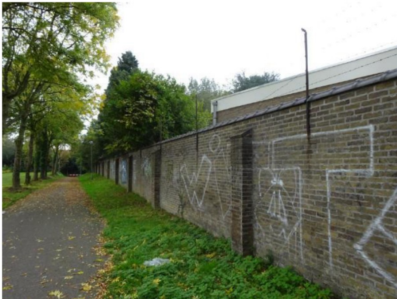
Figuur 6 - De kloostermuur aan de zijde van de Weg langs de Carmel; de bovenzijde is voorzien van nokvorspannen. Delen van de muur zijn ook voorzien van prikkeldraad.
