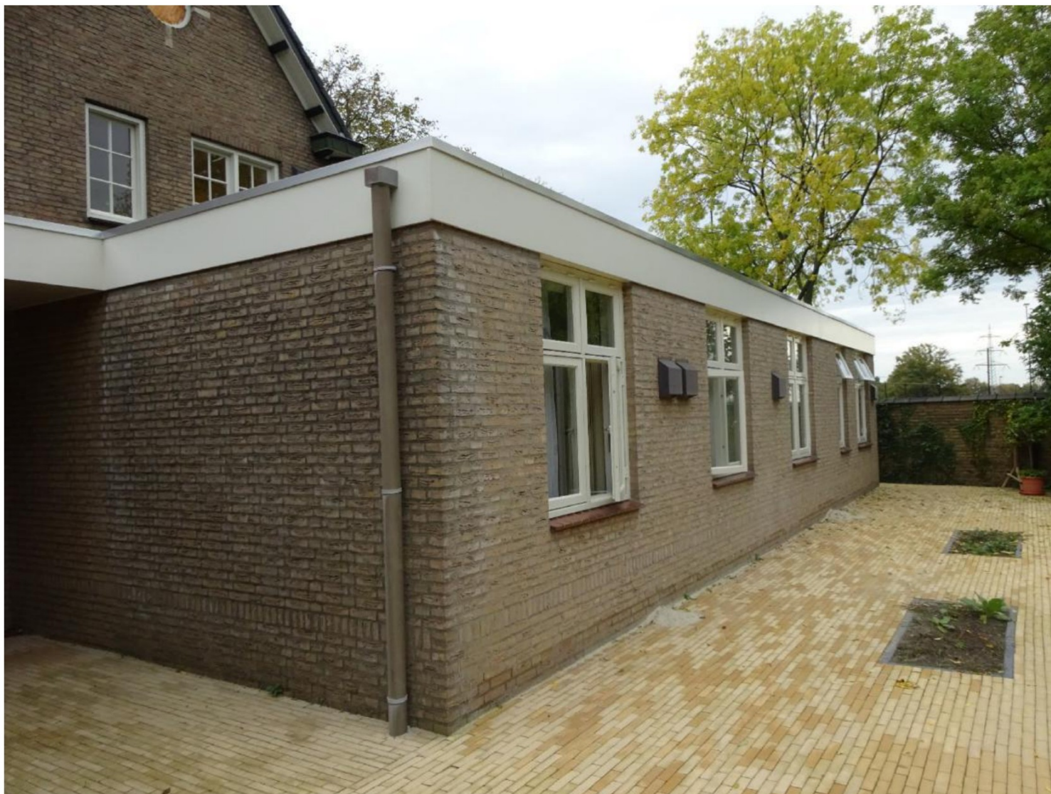
Figuur 24 - Verblijfsruimte uit 1986 - dit deel wordt gehandhaafd.
