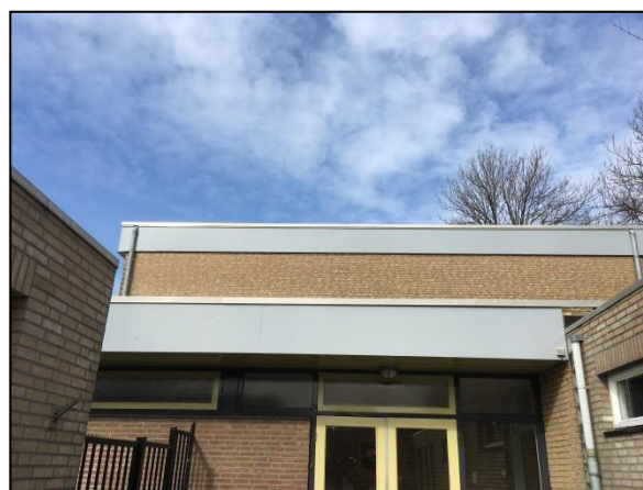
Figuur 11. Geschikte spleten aanwezig onder de dakrand waar vleermuizen gebruik van kunnen maken.
