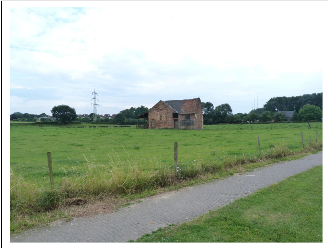
Foto 1. De onderzoekslocatie gezien vanaf de straatzijde (Oude Pastorie).
