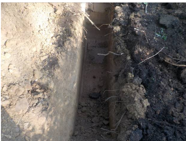
Foto 5: Sleuf 23a onder asfaltverharding.
