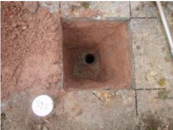
Foto 13: Boring 59 Fundering van baksteen onder gezaagd asfalt. Let op uniforme samenstelling en kleur van de verbrokkelde baksteen.
