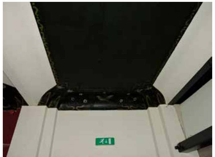
23. Het plafond heeft in dit gedeelte een merkwaardige afwerking, die niet lijkt te passen in de traditionalistische vormtaal van de rest van het pand. De beschikking is van jonger datum
