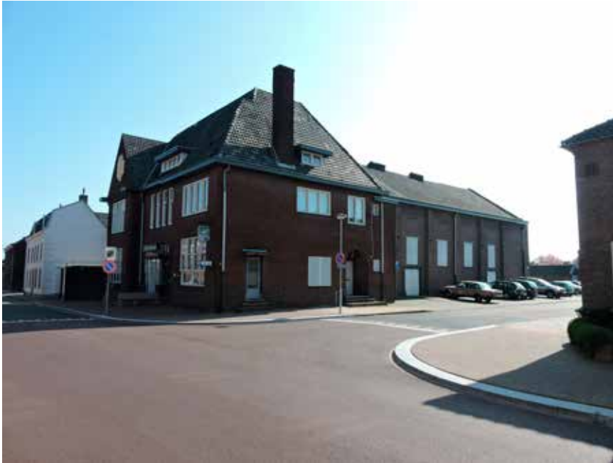
1. Het pand in zijn totaal, op de hoek van Burg. Janssenstraat en Luciastraat
