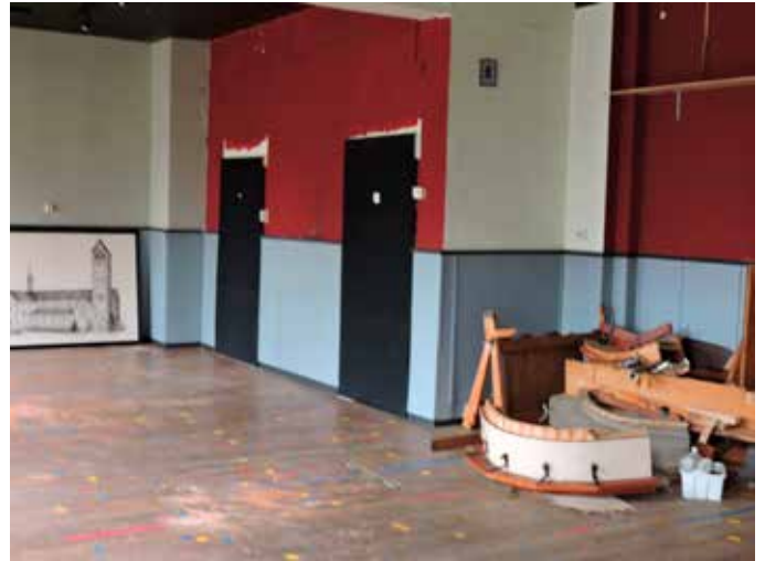
21. De noord-oostelijke hoek van de ruimte aan de straat. De twee deuren naar de ruimtes er achter zijn dichtgezet
