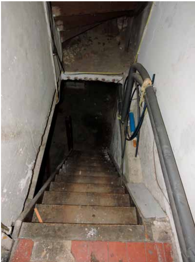
55. Tot slot de trap naar de kelder onder de voorbouw....
