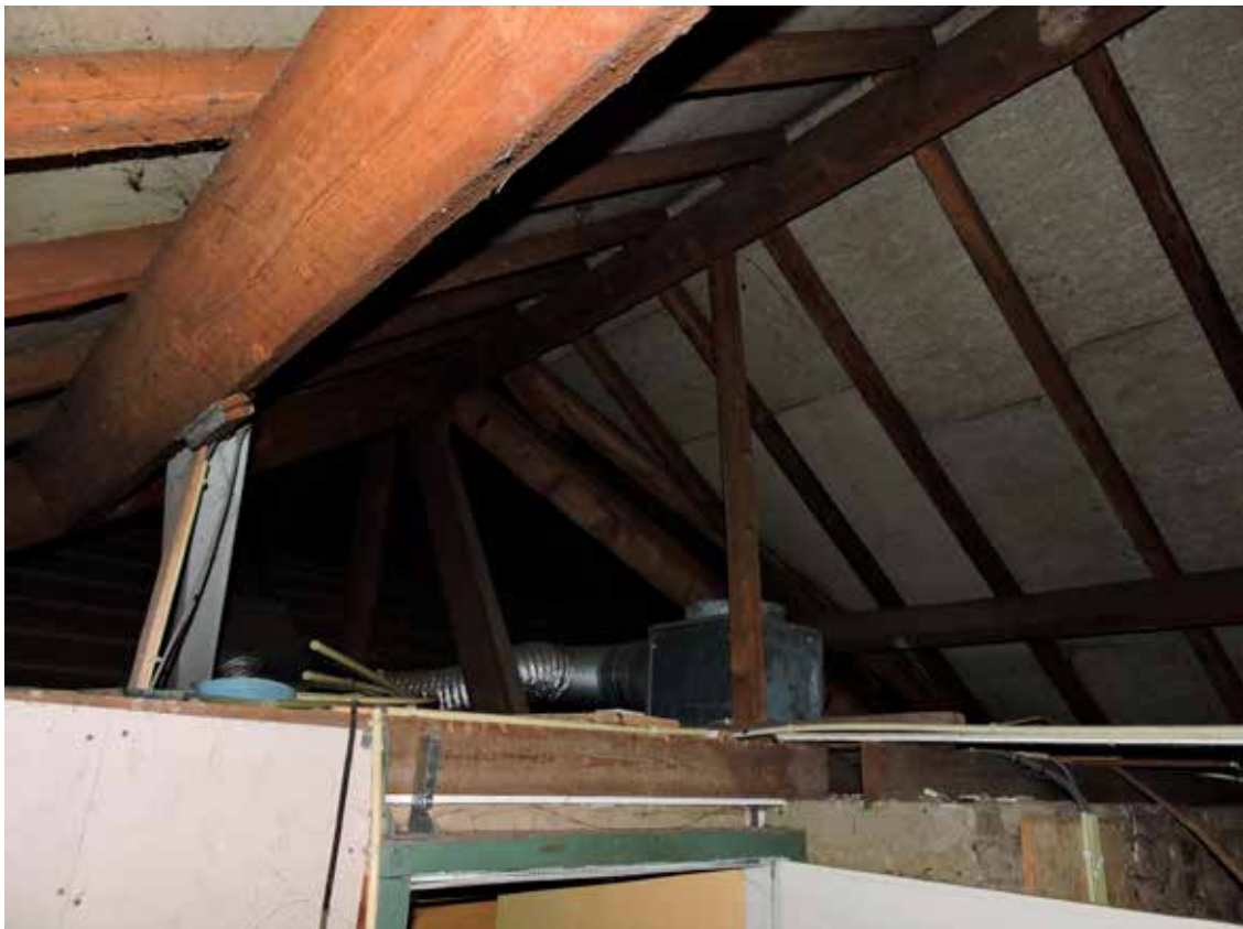
54. Doorkijk naar het dak van de aanbouw aan de straat
