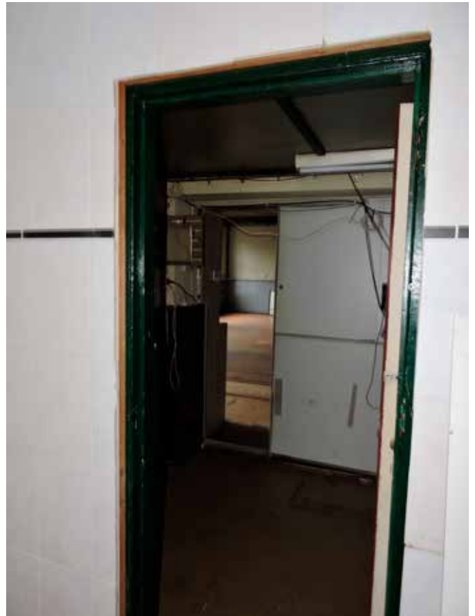
35. Blick richting de grote zaal waaruit duidelijk blijkt dat het pand vele malen is aangepast en verbouwd met een doolhof als gevolg
