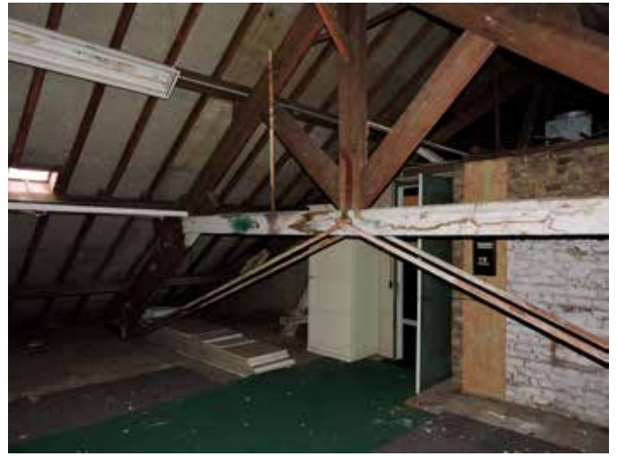
49. De tegenkant met het eerste deel van de zolder van de oudbouw. Om de enorme spatkrachten op de muren, als gevolg van een vrij flauwe dakhelling, op te vangen zijn de spanten versterkt met trekstangen
