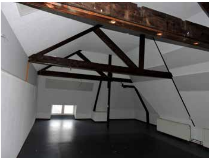
46. De zolderruimte van de aanbouw uit 1932
