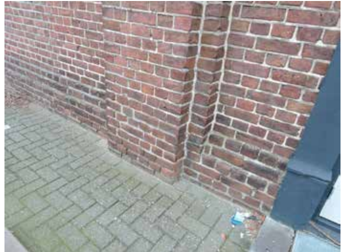
9. Een beeld van de opbouw van de gevel
