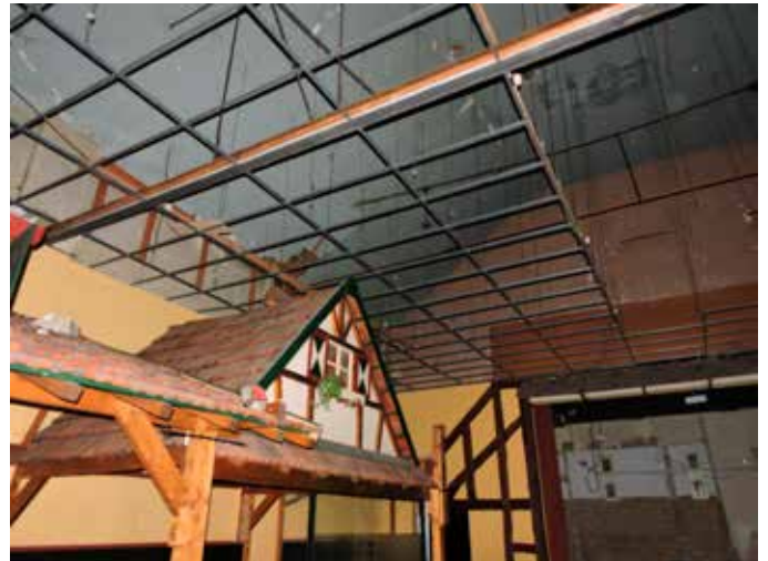
31. Het hoge, geknikte plafond uit de eerste bouwphase is later weggewerkt achter een verlaagd systeemplafond
