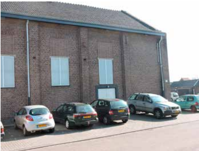
5. De rest van dat bouwdeel. De ramen zijn verkleind, de grote deuren zijn later toegevoegd. De risalieten verstevigen het muurwerk dat verder gekenmerkt wordt door spaarvelden
