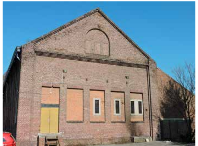
6. De achtergevel, die meteen laat zien dat de helling van het zadeldak vrij gering is. de ramen op de begane grond zijn authentiek, de deur is een uitgebroken raam. In de rondboog zaten drie later dichtgemetselde raampjes
