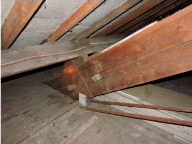
52. Die zijn met beugels aan elkaar bevestigd. Tegen het losraken daarvan zijn tussen de baddings kielen geplaatst die de beugels desgewenst weer op spanning konden brengen
