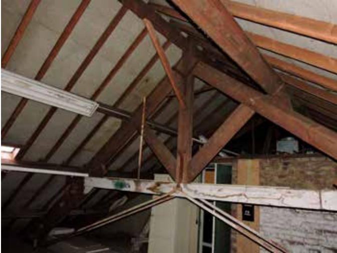
50. Ook de rest van de constructie is op elke verbinding versterkt en gezeurd met ijzeren verbindingsstukken
