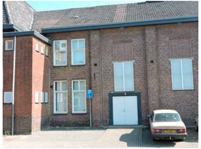
4. De aansluiting op het restant van het oorspronkelijke gebouw
