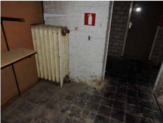
34. De vloeren zijn belegd met zwarte keramische plavuizen uit de eerste bouwphase
