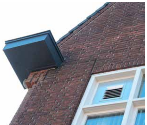
15. Detail van de dakgoot
