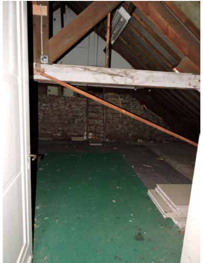
47. De overgang van het bouwdeel uit 1932 naar het oorspronkelijke gebouw met op de achtergrond een brandmuur
