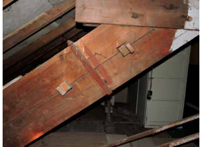
51. De spantbenen zijn uitgevoerd in dubbele, gestapelde baddings
