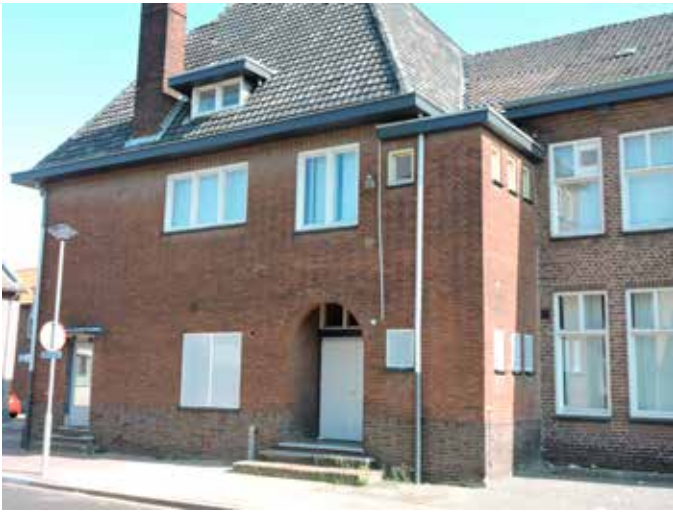
3. De gevel aan de Luciastraat, met rechts in het nieuwe stuk uit 1932 de deur van de bovenwoning. De uitbouw bergt de trap naar de verdieping
