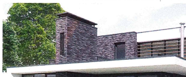
Installaties weggewerkt en opgenomen in de architectuur
