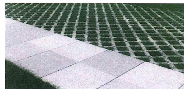
Betontegels met grasbetonstenen gecombineerd
