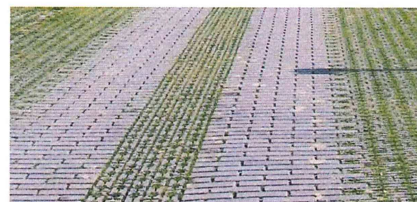
Karrensproten van klinkers in grasbetonklinkers
