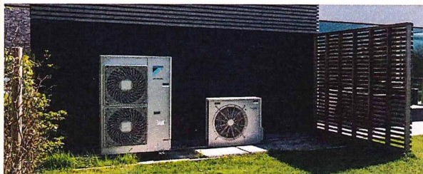
Geen zichtbare installaties tegen gevel
