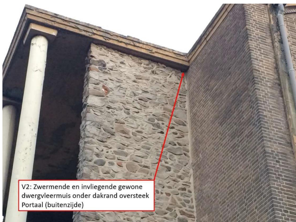
Figuur B2: Locatie van verblijfplaats V2 in de gevel van de Michaelkerk
