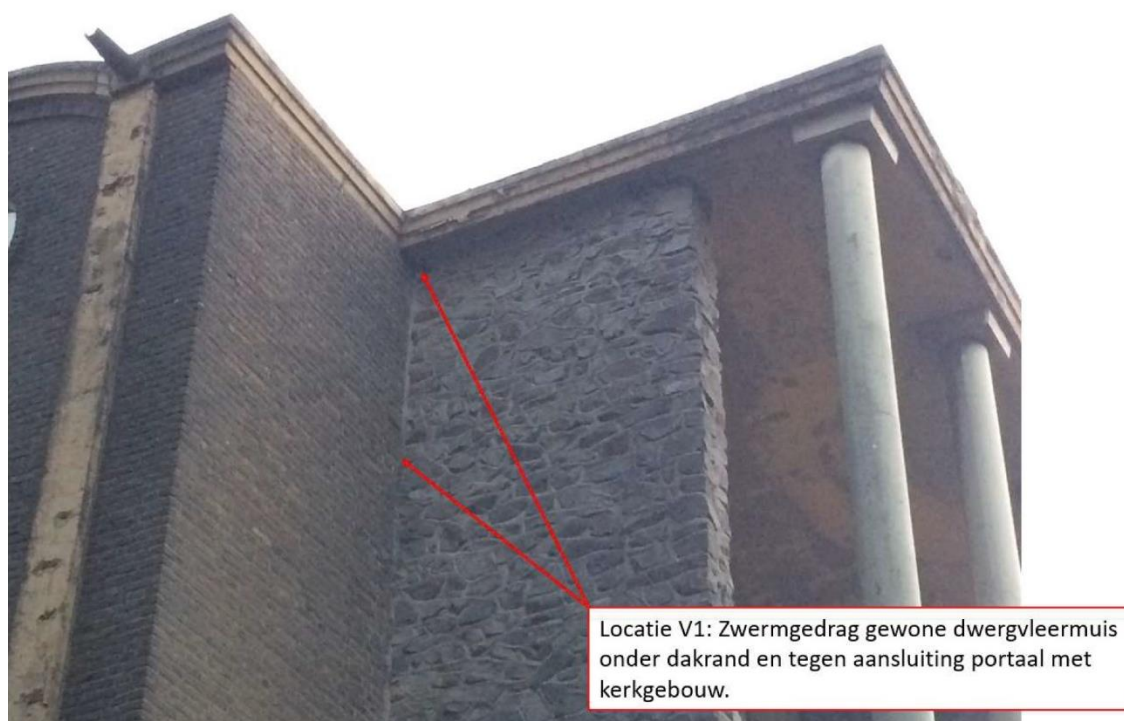
Figuur B1: Locatie van verblijfplaats V1 in de gevel van de Michaelkerk
