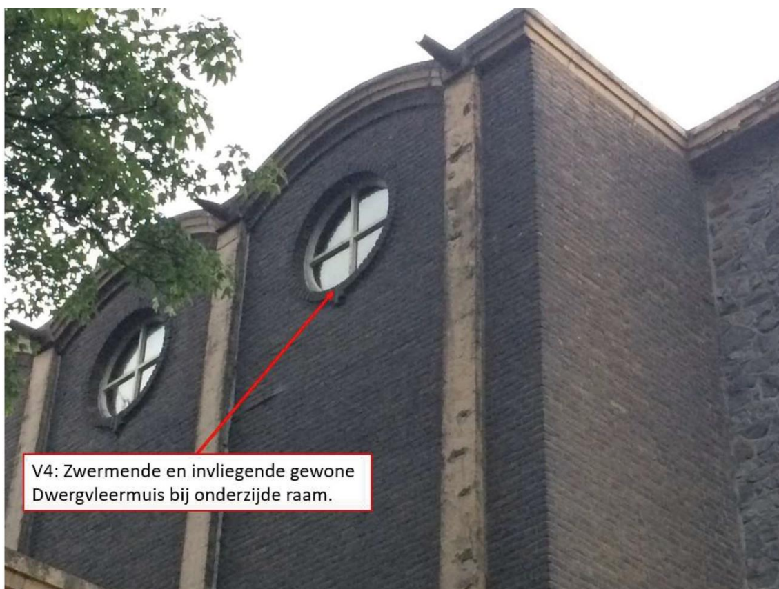
Figuur B4: Locatie van verblijfplaats V4 in de gevel van de Michaelkerk
