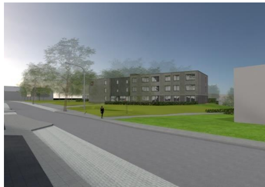
Figuur 14: De voorzijde van het gebouw, Gezien van grotere afstand.
