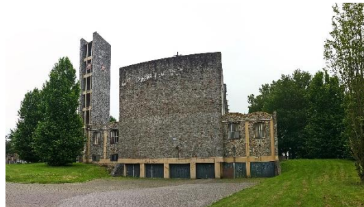
Figuur 4: Kerkgebouw gezien vanuit noordelijke richting.
