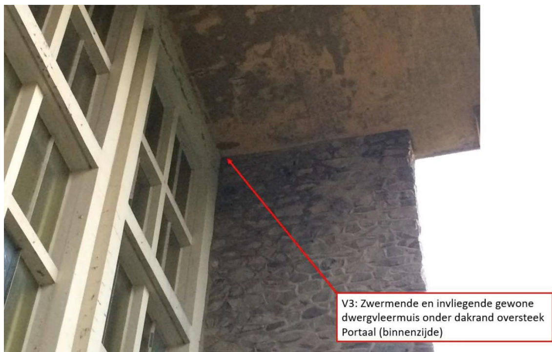
Figuur B3: Locatie van verblijfplaats V3 in de gevel van de Michaelkerk
