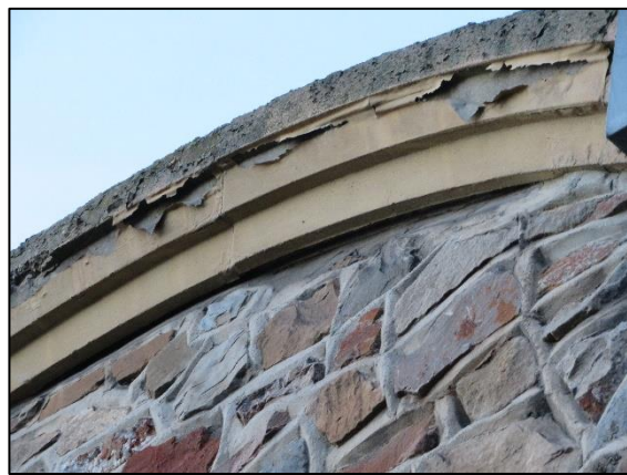
Figuur 10. Geschikte spleten onder dakrand voor gierzwaluw en vleermuizen.
