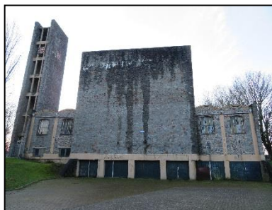
Figuur 4. Achterzijde kerkgebouw met garagedeuren aan onderzijde.
