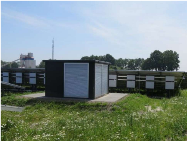
Figuur 7 Illustratie van plaatsing invertors (de witte kastjes achter de panelen)
