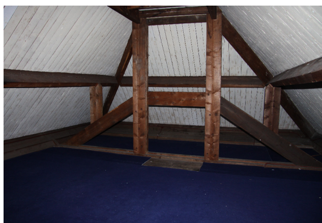
De zolder heeft geen invliegopeningen waardoor deze niet toegankelijk is voor vleermuizen
