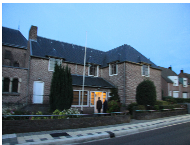
Het dak van pastoriewoning is recentelijk vervangen
