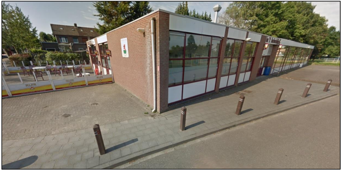
Bestaand clubgebouw (bron: Google StreetView)
