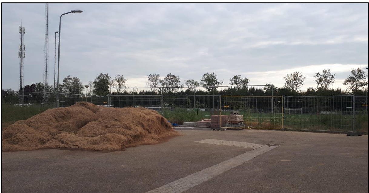
Figuur 52. Weergave van overige aanwezige bovengrondse infrastructuur. Bron: locatiebezoek BeoBOM, 2 september 2022.
