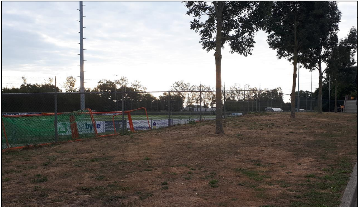
Figuur 51. Weergave van een deel van de bovengrondse infrastructuur, inclusief terreinbegrenzingsen en beplanting. Bron: locatiebezoek BeoBOM, 2 september 2022.
